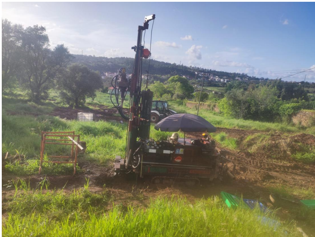
Figura 10 – Máquina de sondagens na S17
