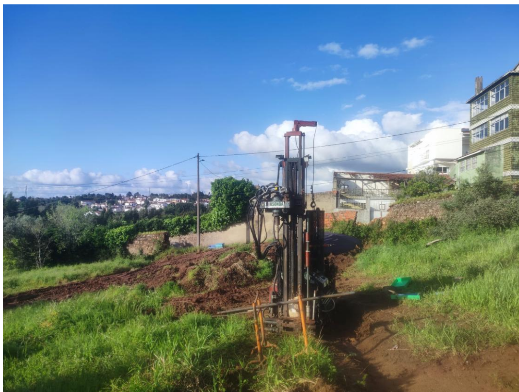
Figura 11 – Outra perspectiva do equipamento de furação
