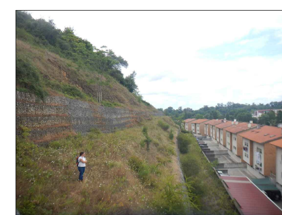
Foto 13 - Vista geral dos taludes, de nascente para poente.
