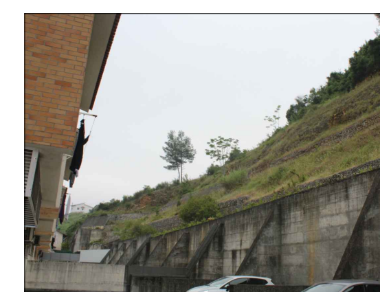
Foto 8 - Muro de suporte em betão, com contrafortes
