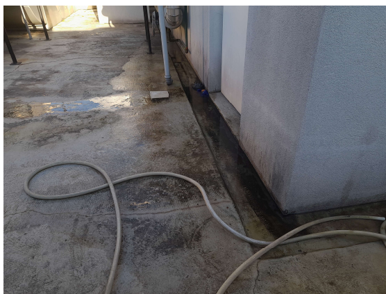
Imagem 4 - Caleira do pavimento do terraço técnico
