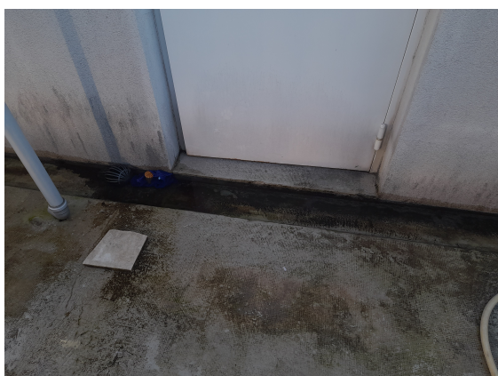
Imagem 4 - Caleira do pavimento do terraço técnico
