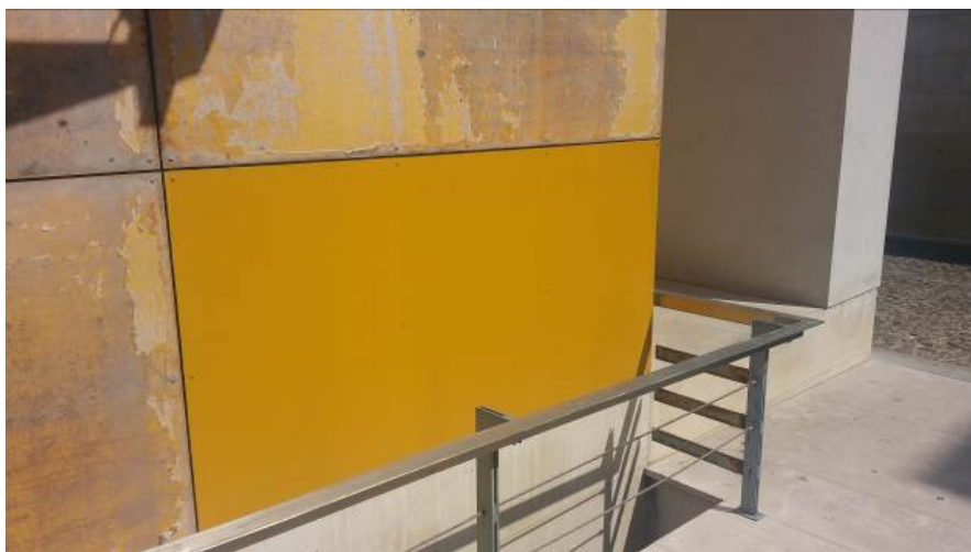
Imagem 3 - Paineis já reparado (aspeto final)
