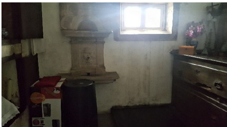
Fotos do edifício existente
