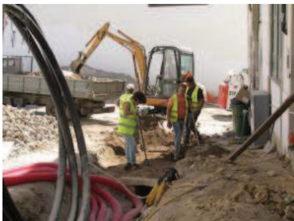
Foto 14 – Limpeza da runa no Largo de São Salvador
