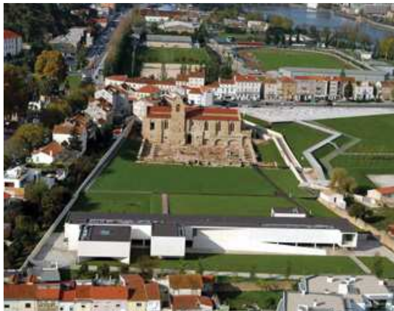
Fotografia 1 - Centro Interpretativo do Mosteiro de Santa Clara-a-Velha 95
