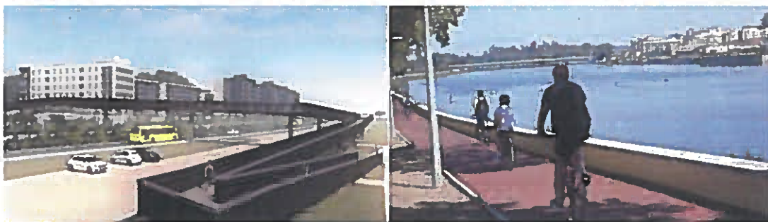
Figuras 82 e 83 – Novo viaduto, pedonal e ciclável sobre a Avenida da Lousã (imagem virtual – construção em curso) / Ciclovia na margem esquerda do Mondego
