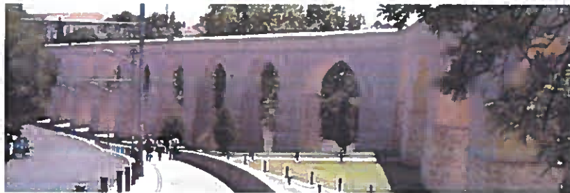
Figura 8 – Aquaduto de São Sebastião
