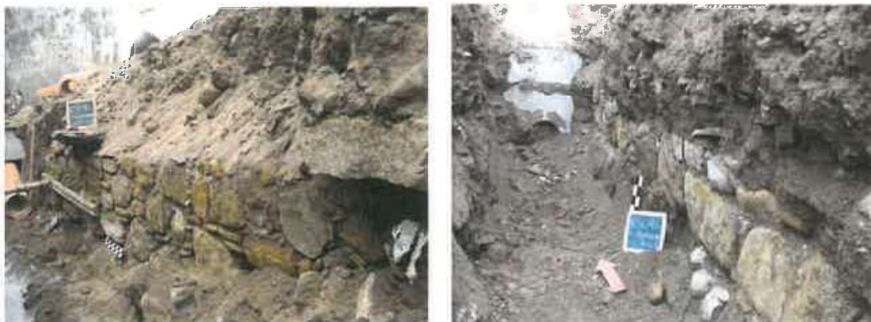
Figura 3 e 4 – Duas das seções do coletor em alvenaria
