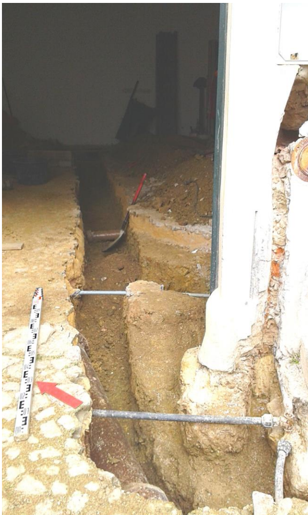
Abertura de vala para colocação de infraestruturas
