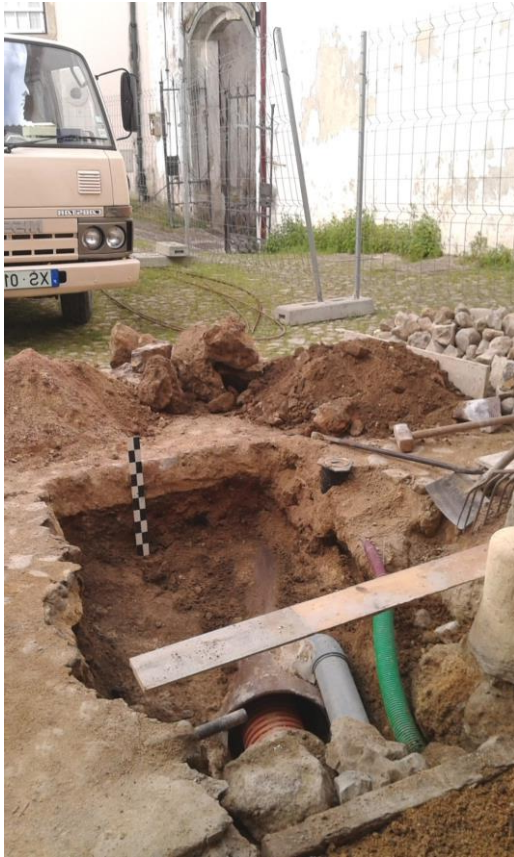
Vários aspetos da abertura de valas exterior do edifício
