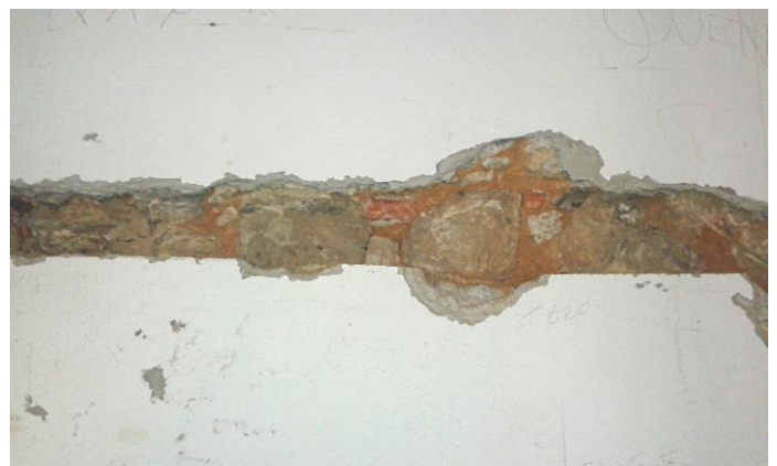
Roços nas paredes interiores do imóvel
