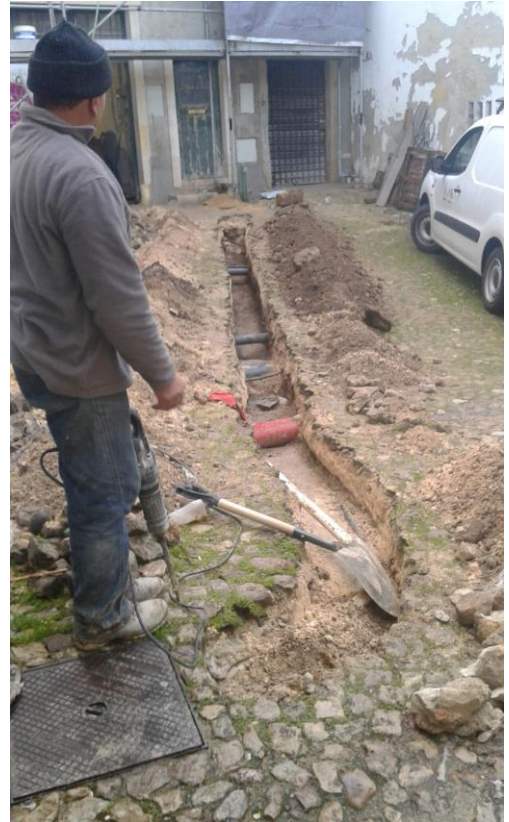
Vários aspetos da abertura de valas exterior do edifício
