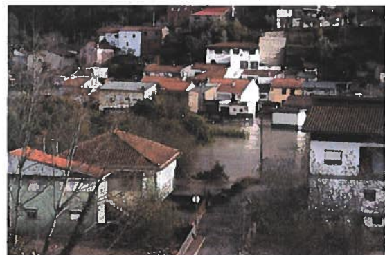
Figura 5.6 – Cheia do rio Ceira em 21 de dezembro de 2019. Localidade do Cabouco
