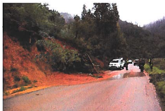
Figura 5.10 – Deslizamento de vertente
