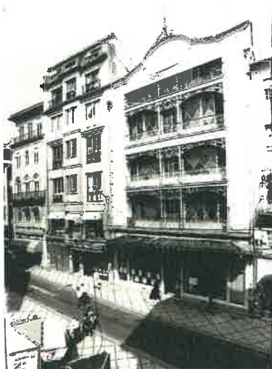
Fig. 7 – Fachada do Imóvel
