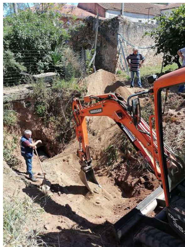
Figura 09 a 11 – Várias fases dos trabalhos de arqueologia, conservação e restauro
