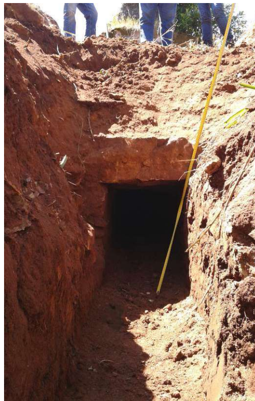
Figura 07 e 08 – Aspeto da estrutura hidráulica, após limpeza mecânica
