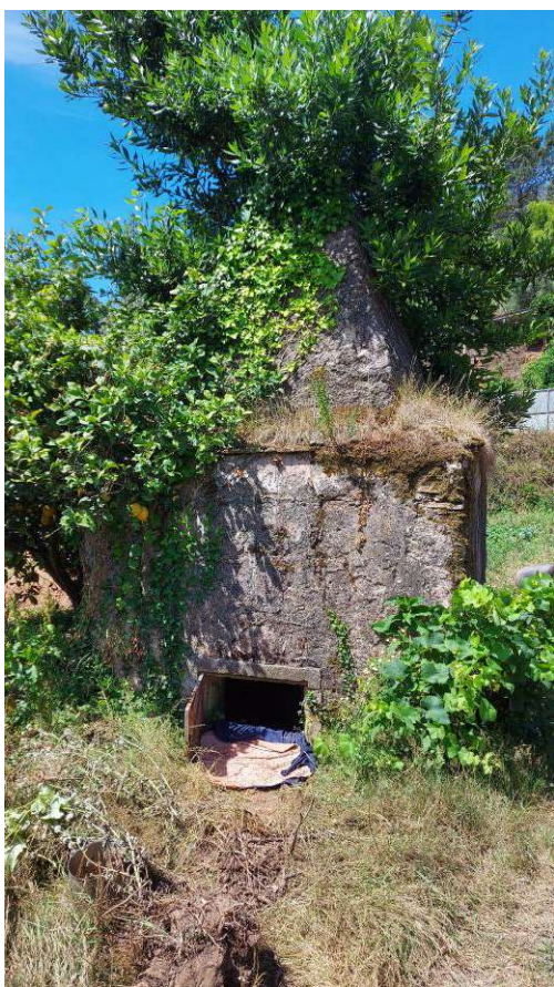
Figura 04 – Mãe-d'água, zona da entrada, lado Este
