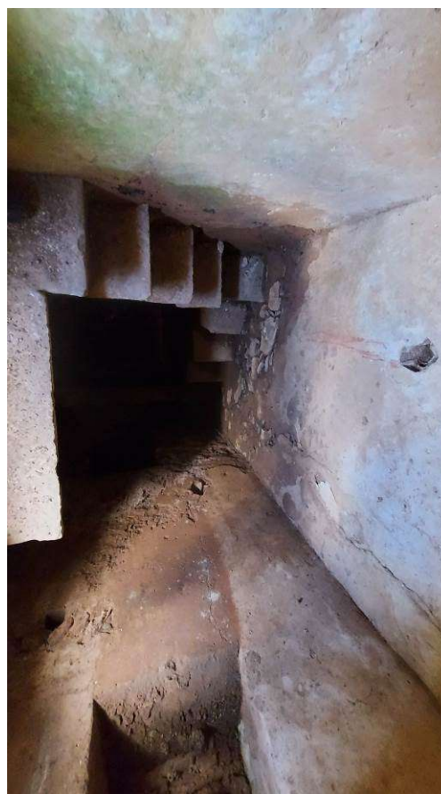
Figura 05 – Mãe-d'água, degraus de acesso à parte inferior
