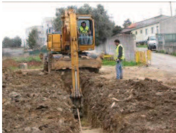
Figura 05 – Escavação para instalação da conduta de águas pluviais
