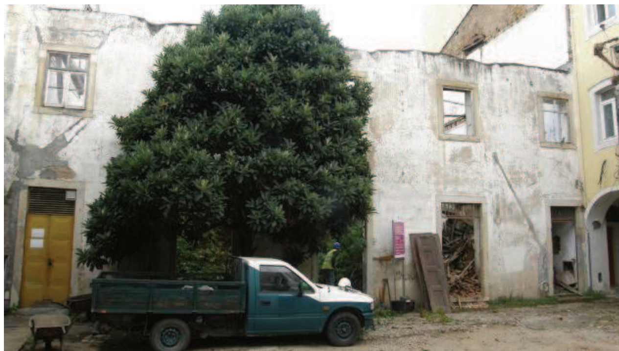
Figura 02 – Aspeto da fachada principal do edifício
