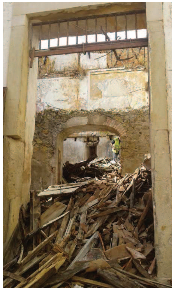
Foto 03 – Aspeto do interior do imóvel antes da remoção do entulho
