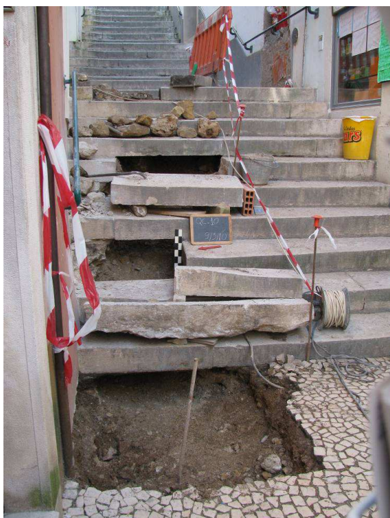
Vala para implantação das infraestruturas subterrâneas
