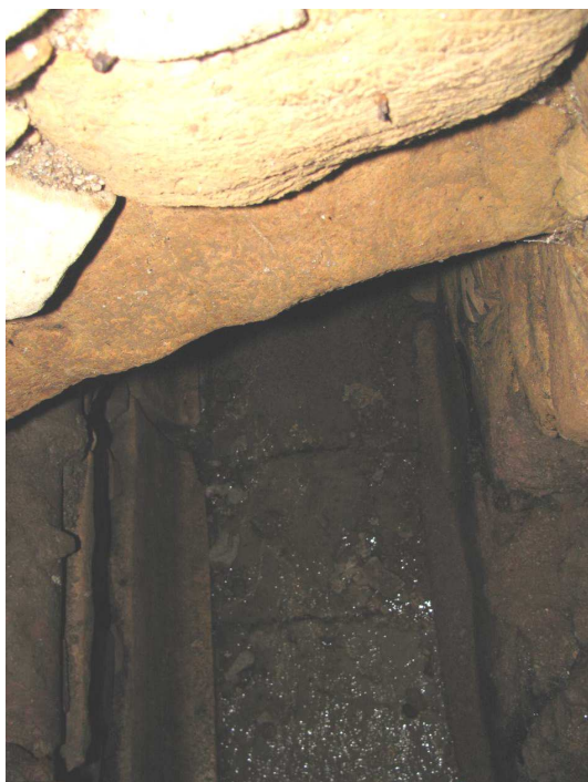
Pormenor do coletor de alvenaria, provável Cloaca romana
