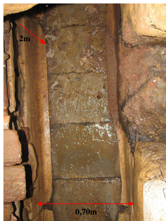
Pormenor do coletor de alvenaria, provável Cloaca romana
