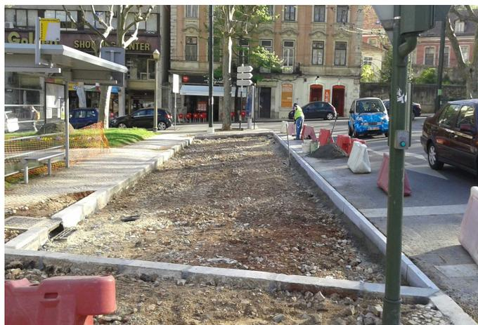
**Fig. 13** - Regularização do pavimento na Av.<sup>a</sup> Sá da Bandeira.
