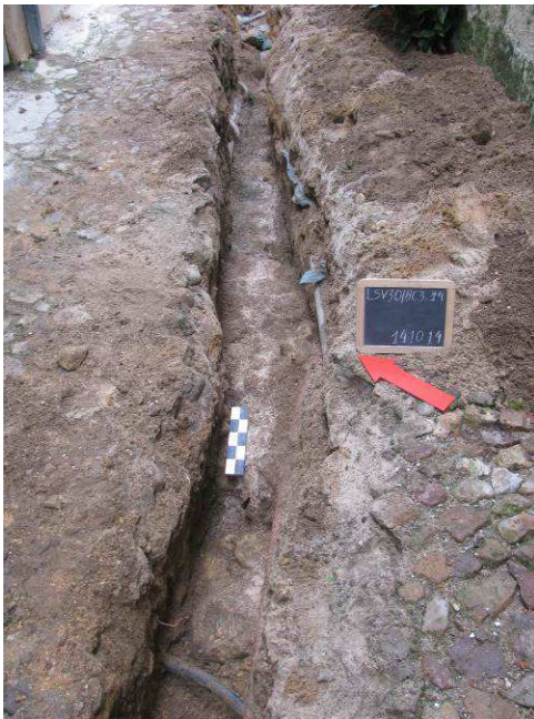
Pormenor da estrutura de alvenaria [E1], registada no Bc. da Carqueja, na vala para instalação da rede de gás.
