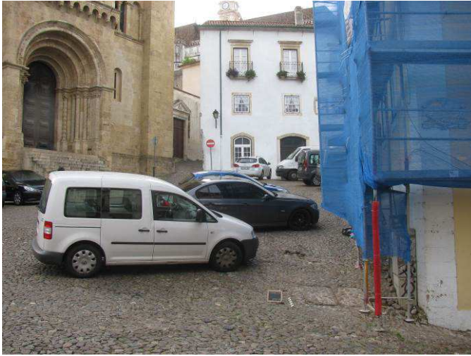
Situação prévia ao início dos trabalhos no Largo da Sé Velha.
