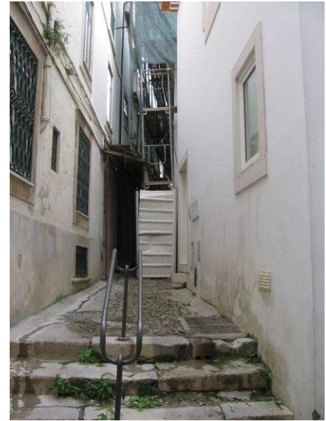
Situação prévia ao início dos trabalhos, na área sudeste do Bc da Carqueja.
