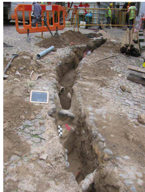
Abertura da vala para instalação da rede de gás no Largo da Sé Velha, com estruturas de alvenaria [E2] e [E3], e diversas infraestruturas pré-existentes.
