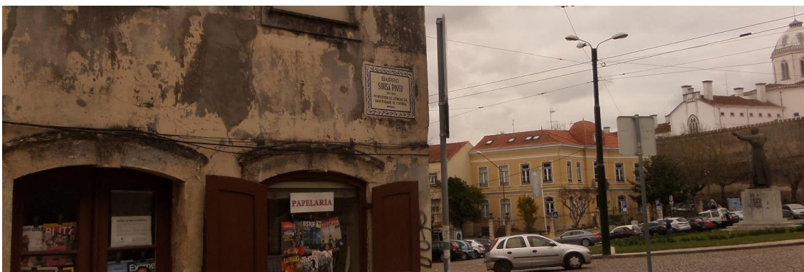
Figura 5 – Edifício em mau estado de conservação localizado na ARU proposta
