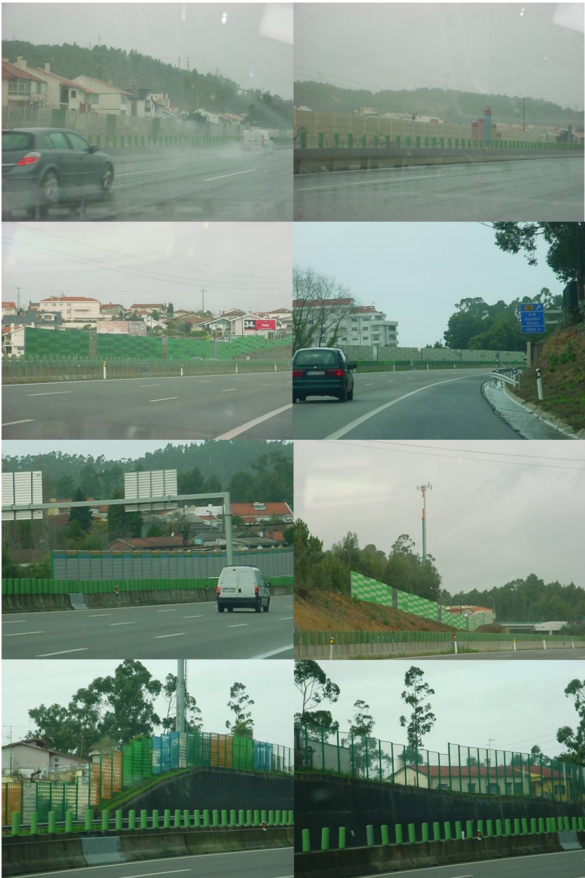
Figura 4-5: Exemplos de barreiras acústicas de diversos tipos na A1.
