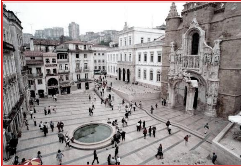
Fig. 4 – Aspeto final após a intervenção.
