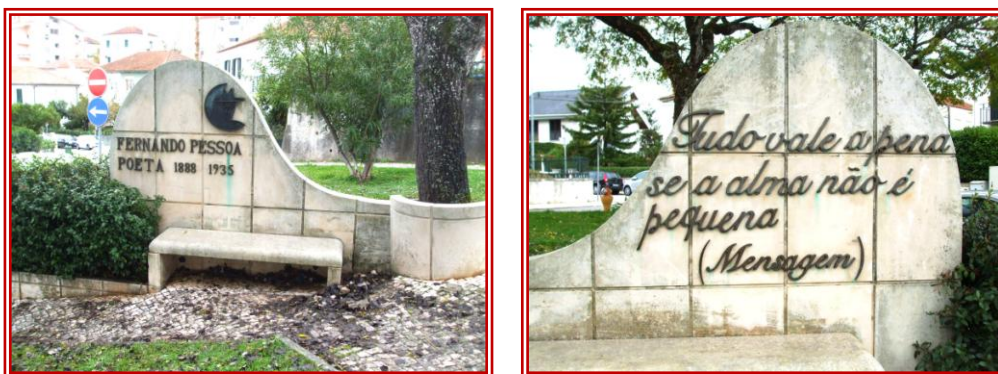
Fig 6 e 7 – Aspetos gerais depois da intervenção
