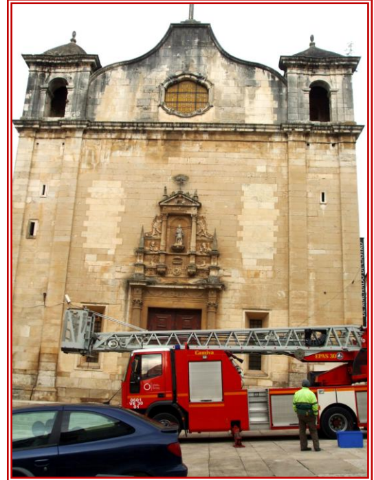
Fig. 4 – Remoção da vegetação aérea, com a auto - escada dos Sapadores.
