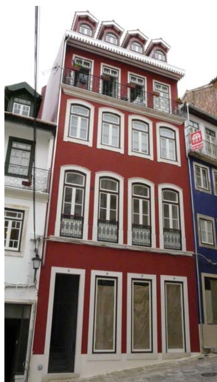
Alçado principal - Depois da intervenção
