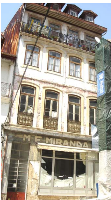
Alçado principal - Antes da intervenção
