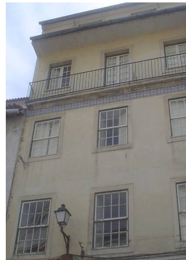
Imóvel antes da recuperação
