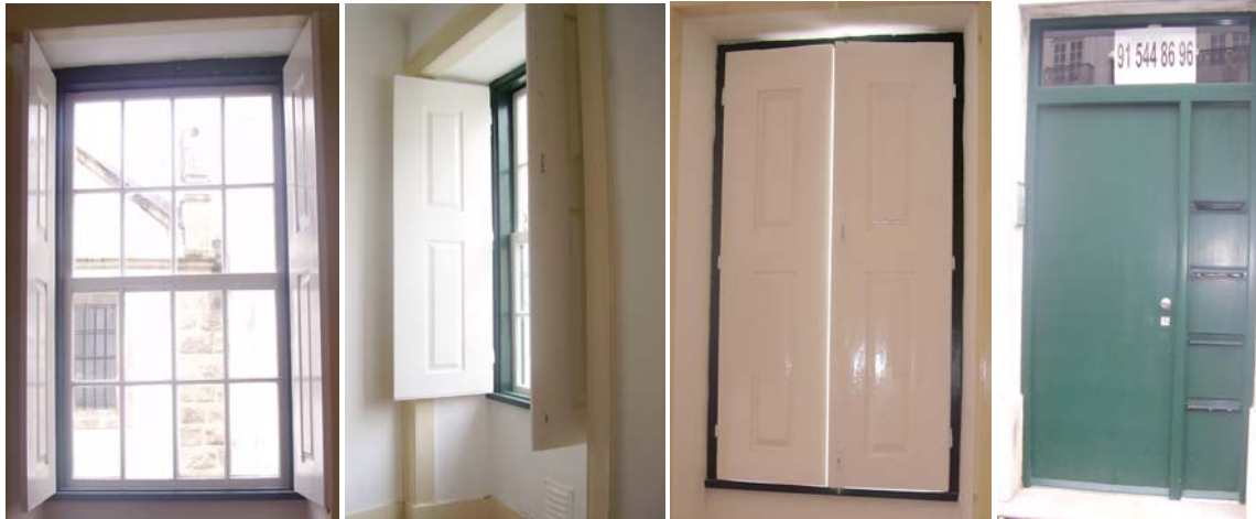
Intervenção nos vãos exteriores
