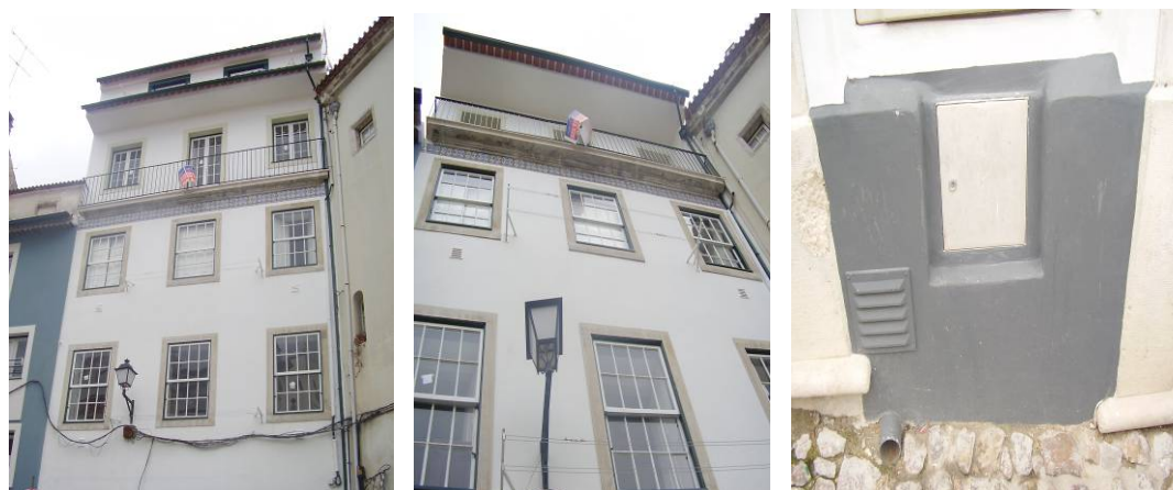
Intervenção na fachada exterior
