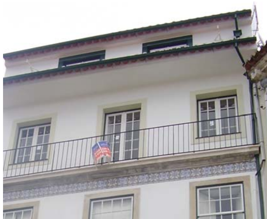
Intervenção no sistema de drenagem pluvial
