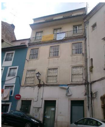
Placas identificativas da obra
