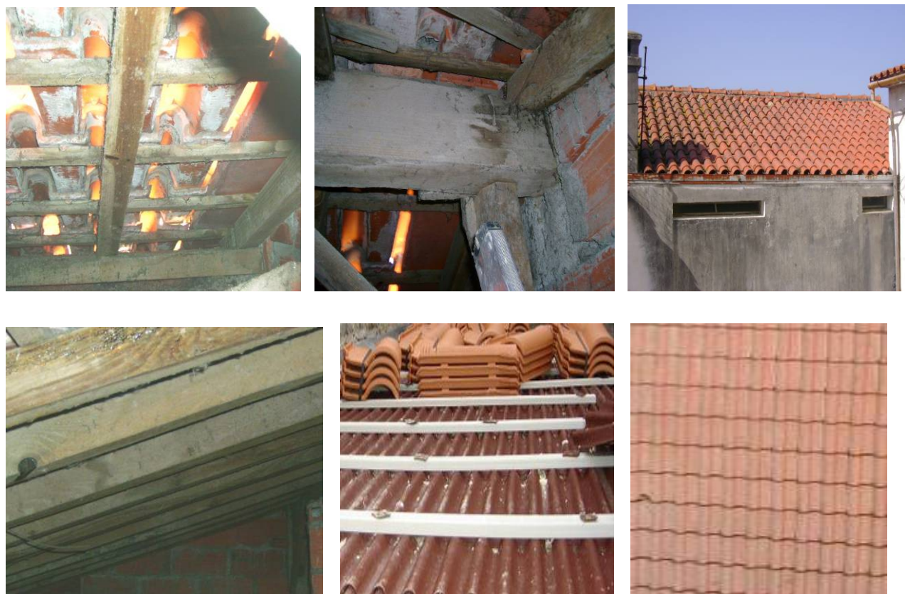
Intervenção na cobertura
