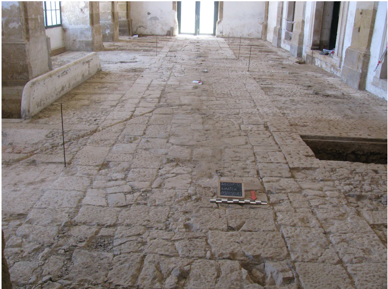
Fig. 6 - Trabalhos de diagnóstico no nartex da igreja. IgCSF.12.
