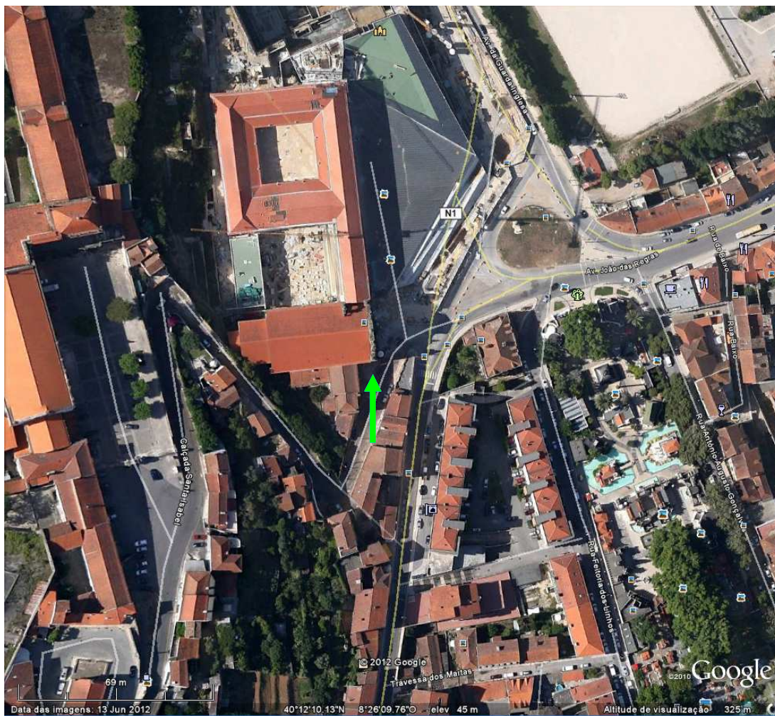
Fig. 1 – Igreja do Convento de S. Francisco ( http://www.googleearth.com acessado em 12 Dez 2012).
