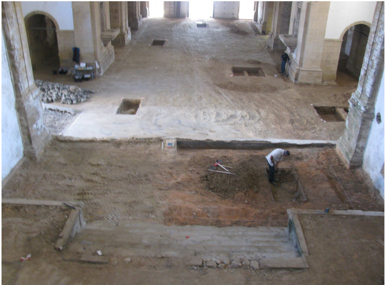
Fig. 5 - Trabalhos de diagnóstico na igreja. IgCSF.12.
