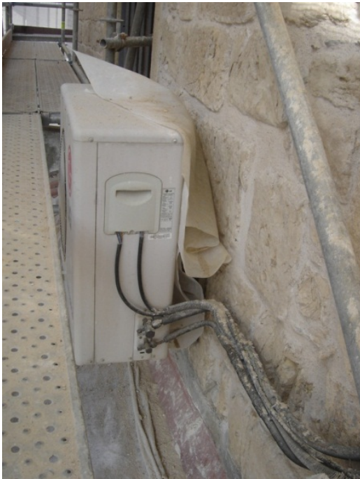
Localização inicial do aparelho exterior de Ar Condicionado
