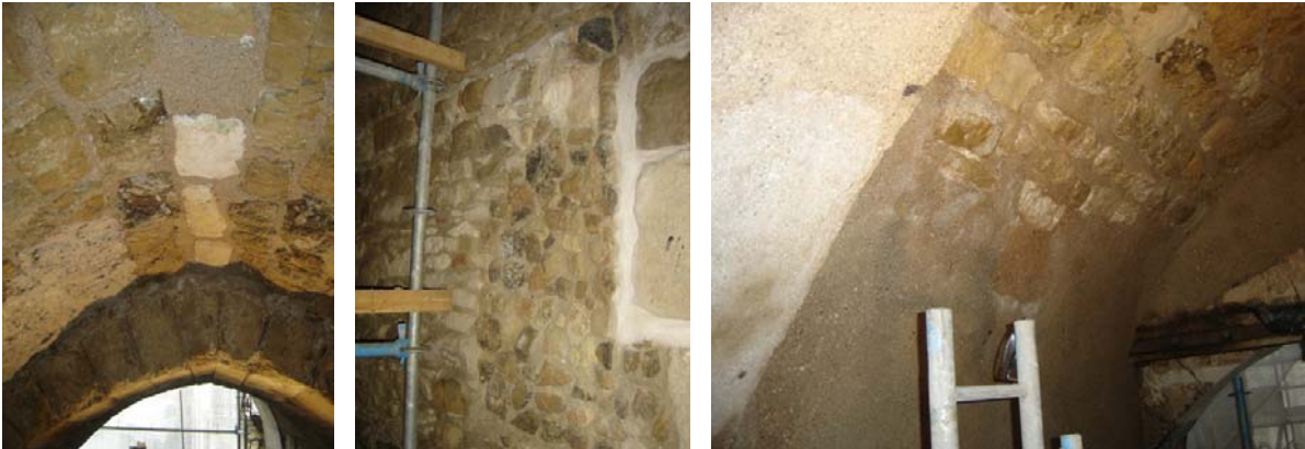
Estado inicial do troço sul do intradorso do Arco de Almedina
