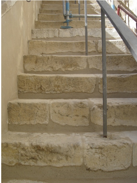
Tratamento de juntas nas escadas da fachada sul.
