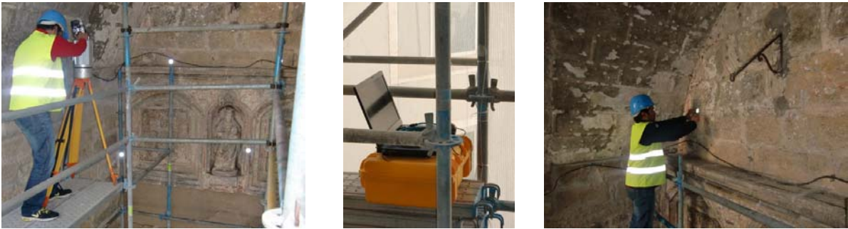
Execução dos trabalhos de levantamento tridimensional e fotogramétrico.
