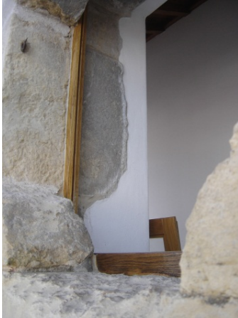
Fase de execução da reparação das caixilharias da Torre
