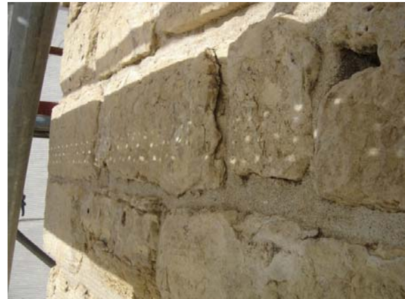
Juntas em cimento "Portland", em destacamento, justificando a utilização de equipamento elétrico ligeiro.
