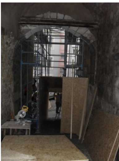
Montagem do túnel sob a Torre e elevação da estrutura dos lados norte e sul.
