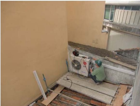
Trabalhos de mudança da localização do aparelho de AC, da fachada da Torre para a cobertura do GCH.
