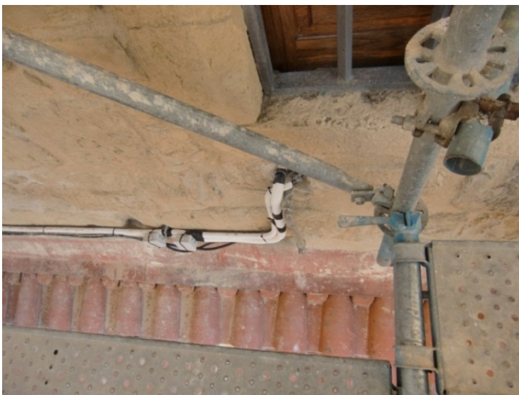
Nova tubagem instalada.
