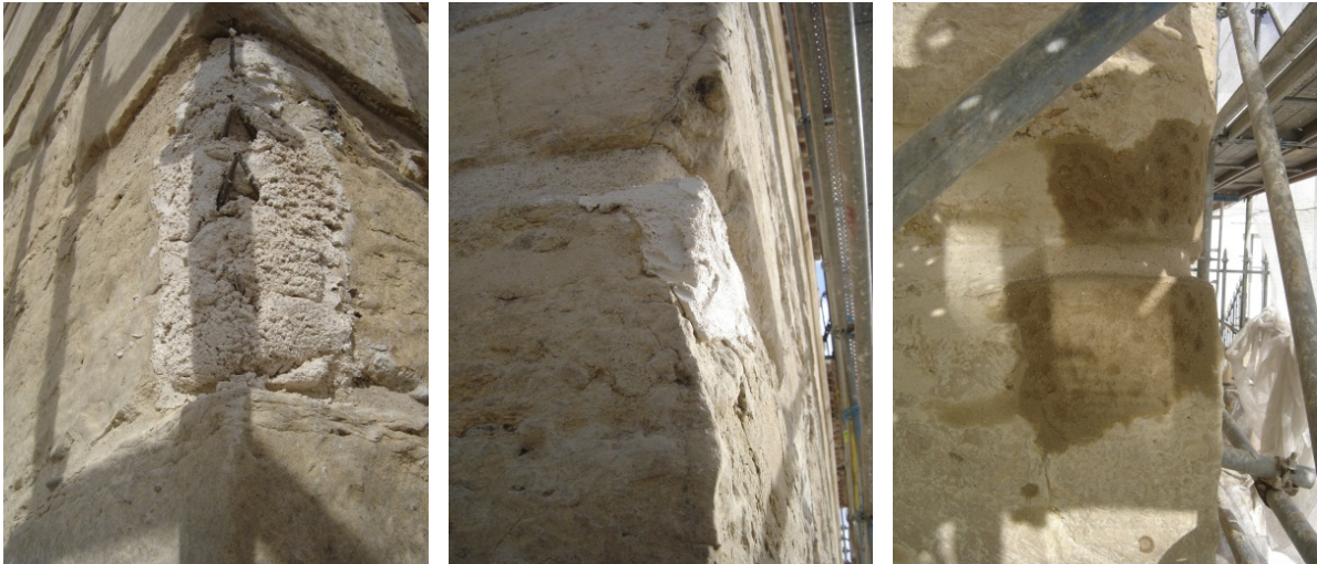
Exemplo de preenchimento de lacunas com argamassa armada.
