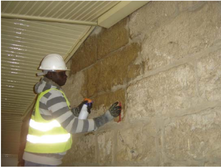
Limpeza de paramentos com escovagem suave e água pulverizada no interior e com água escorrente no exterior.
