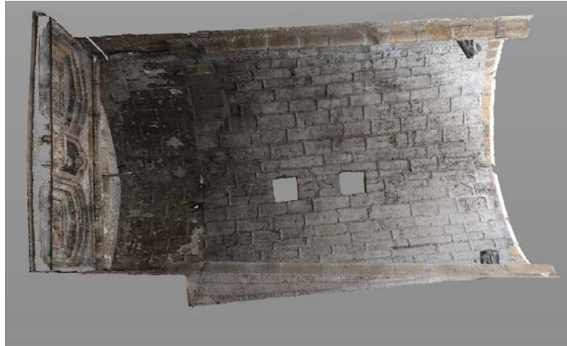
Imagem gerada por nuvem de pontos coloridos, com perspetiva do intradorso da abóbada Superior
