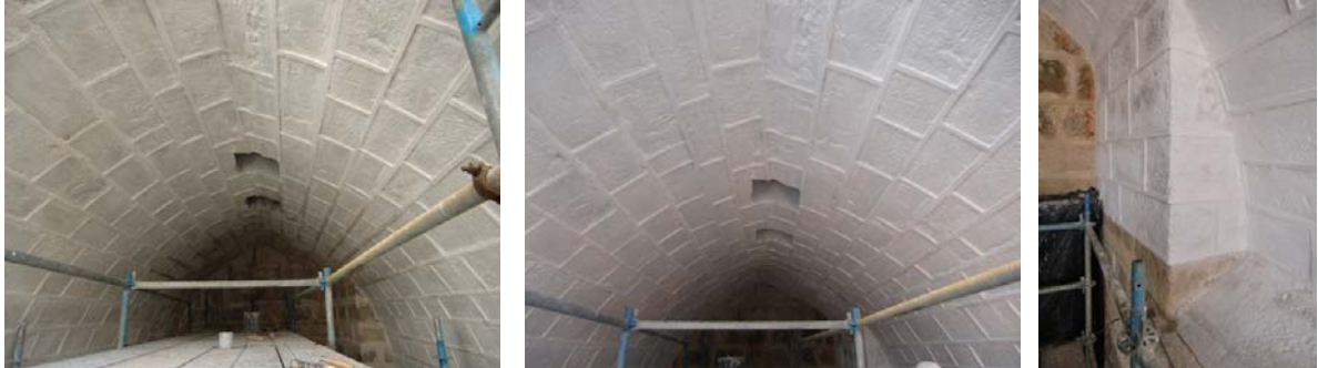
Fases da caiação da abóbada.
