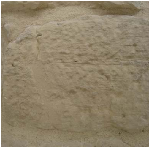
Exemplo de micro-estucagem depois de esponjada e com correção cromática.
