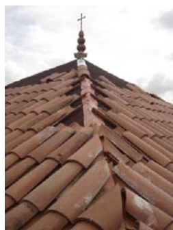
Levantamento e reposição de telhado, com substituição de fixações e remates
