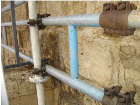
Viga parte do suporte do andaime poente, na fachada sul e estrutura na fachada nascente, antes de ligada ao restante
