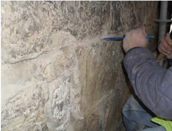
Saneamento de juntas recorrendo a equipamento manual e a equipamento elétrico ligeiro.
