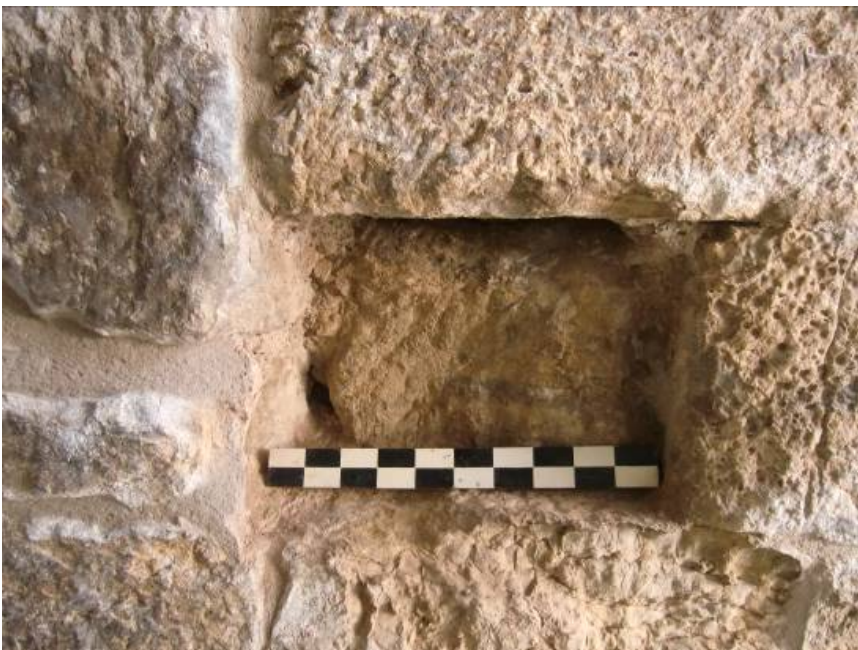
Fotografia de pormenor de uma das zonas de encaixe de travejamento
