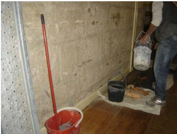
Trabalhos de micro-estucagem no piso superior do GCH.
