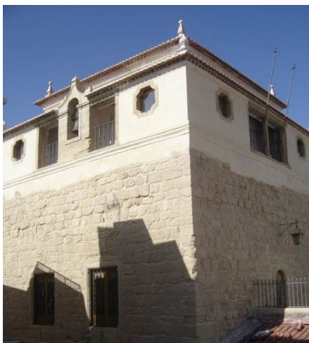
Fachada poente, depois da intervenção
