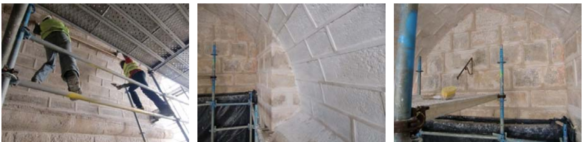
Fases da reparação e execução das juntas fingidas na abóbada.
