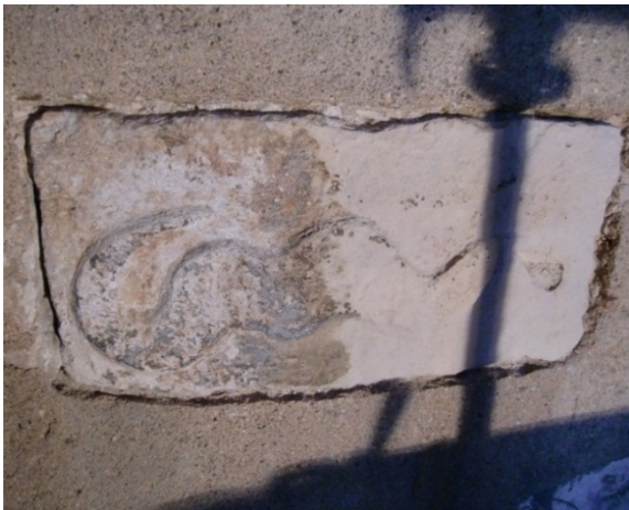
Escudos com a serpente e com o dragão, depois da intervenção e já preparados para a aplicação de molde em silicone
