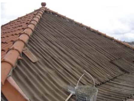
Levantamento e reposição de telhado, com substituição de fixações e remates
