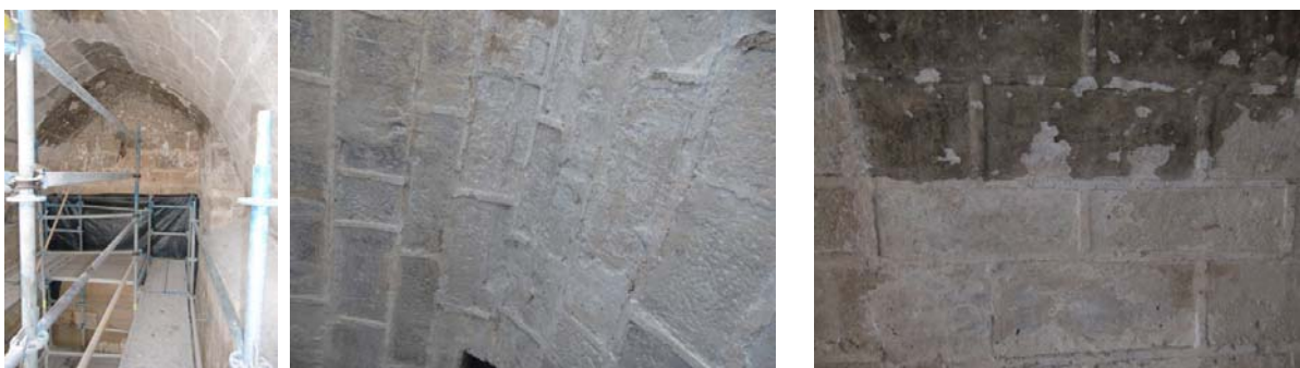
Estado da abóbada, das juntas fingidas na pedra após a limpeza e na zona de tijolo barrada a cal, durante a limpeza.
