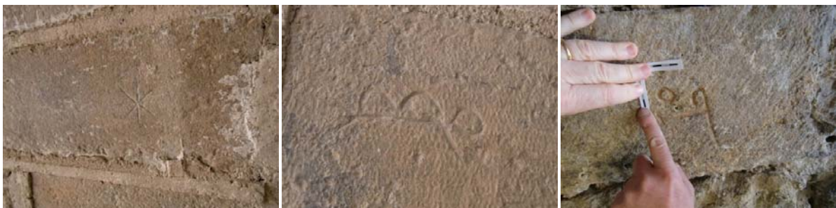
Três das muitas siglas de canteiro descobertas nas abóbadas de pedra, depois de limpas.
