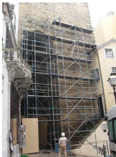
Montagem do túnel sob a Torre e elevação da estrutura dos lados norte e sul.
