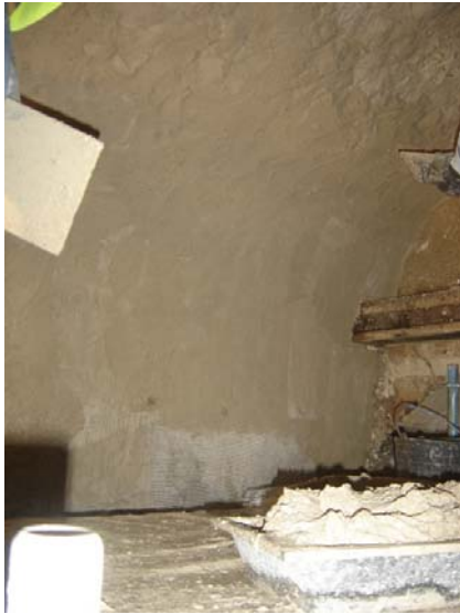
Execução de reboco no intradorso do Arco de Almedina
