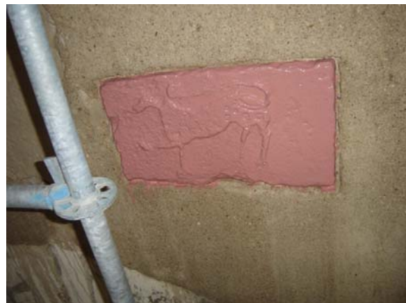
Escudos com a serpente e com o dragão, depois da intervenção e já preparados para a aplicação de molde em silicone
