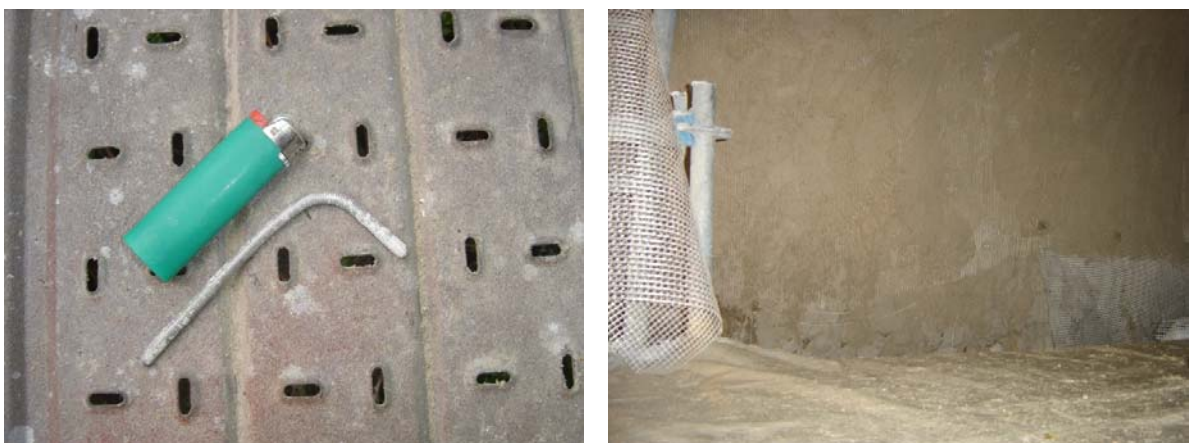
Imagem de grampo de inox e rede de fibra de vidro, utilizados no reboco do intradorso do Arco de Almedina
