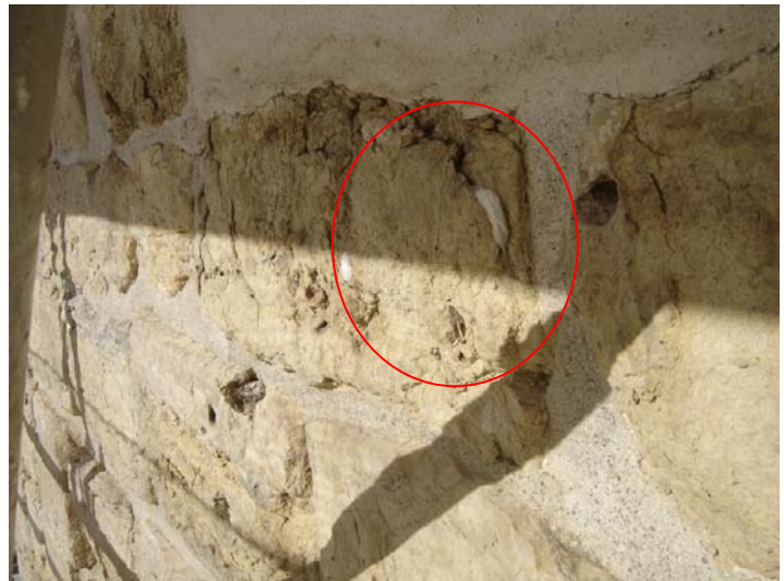
Paramento depois da limpeza e exemplo de pré consolidação com colagem por resina epóxica.
