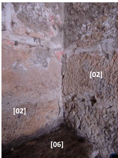
Fotografia de pormenor da zona de encosto da [03] à [02], sendo igualmente visíveis os vestígios de pintura a carmim e as juntas fingidas.
