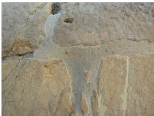
Diversas amostras de argamassa de preenchimento de junta, preteridas pela cor e pela textura.
