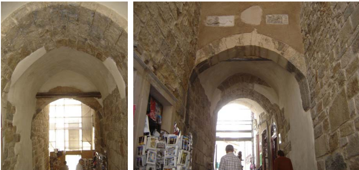
Aspetto final dos trabalhos de reboco no intradorso do Arco de Almedina.
