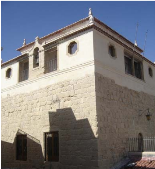
Aspetto final dos trabalhos nas fachadas poente e sul da Torre de Almedina
