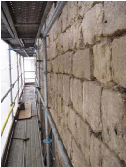
Paramento depois da limpeza e exemplo de pré consolidação com colagem por resina epóxica.
