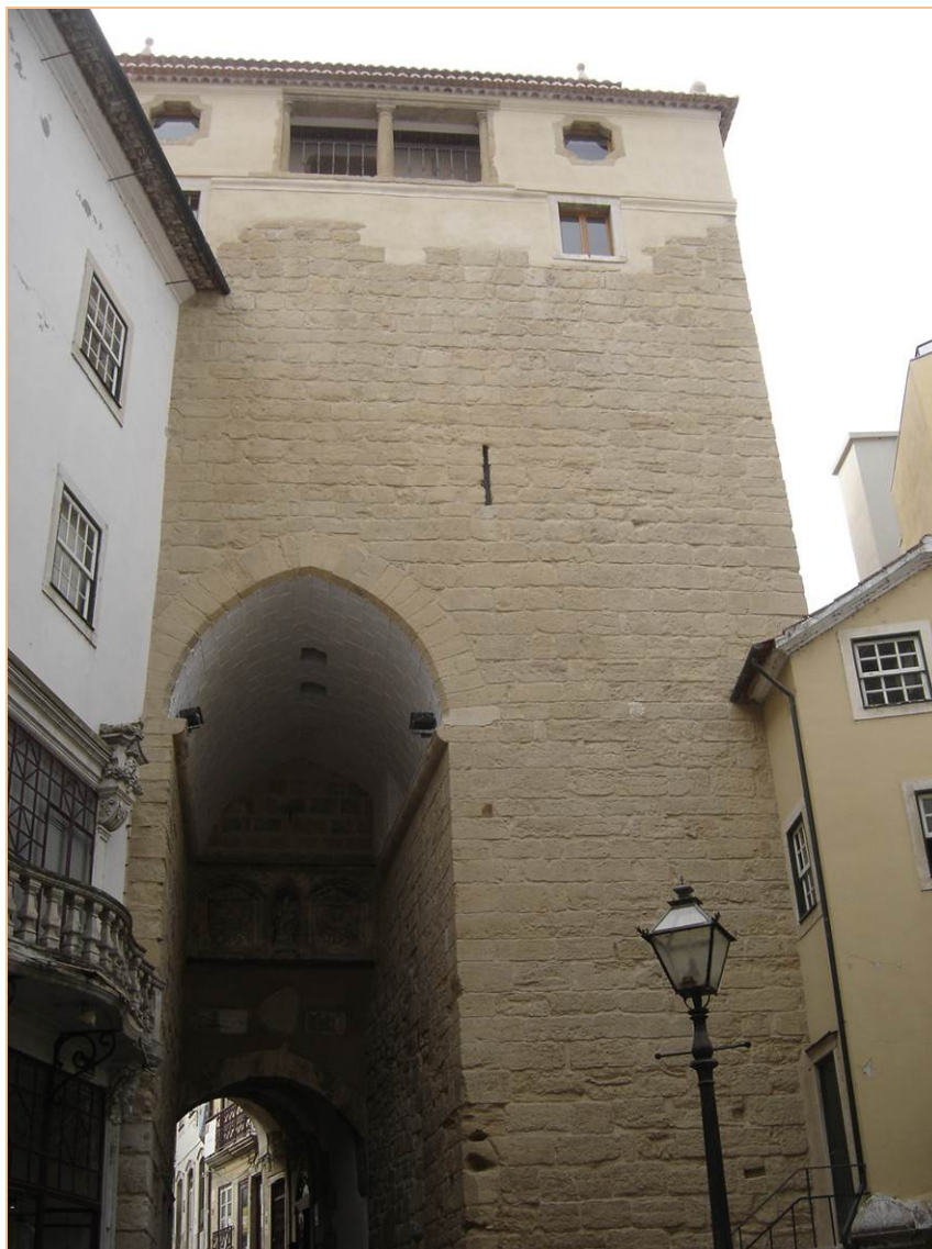
“TORRE DE ALMEDINA 2ª FASE – RECUPERAÇÃO DE FACHADAS”
