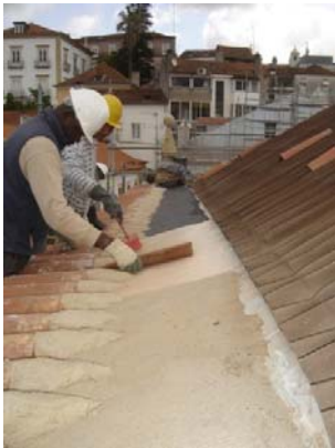
Pormenores construtivos, na ligação ao beirado
