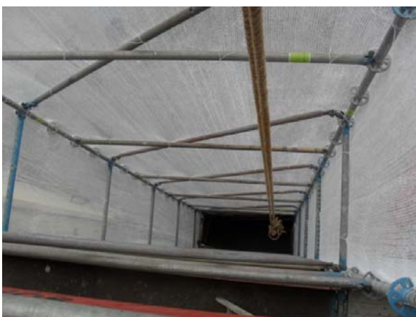
Espaço de funcionamento do guincho andaime finalizado, já com a tela envolvente.
