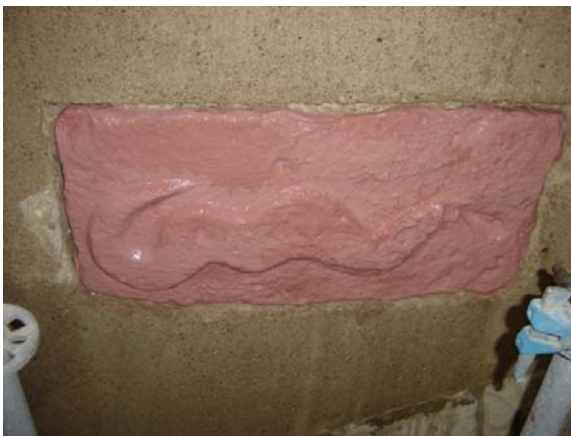
Aplicação de molde em silicone nos escudos com a serpente e com o dragão
