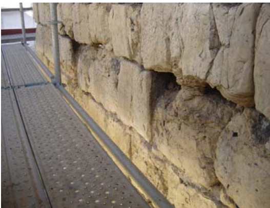
Alvenaria limpa e com juntas e lacunas saneadas, prontas para preenchimento.
