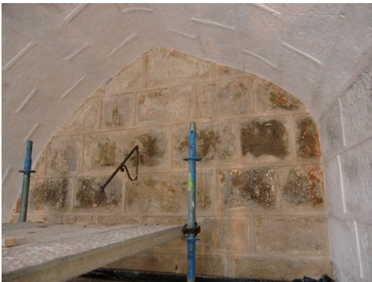
Reparação e execução das juntas fingidas na parede do fundo e caiação final da abóbada.
