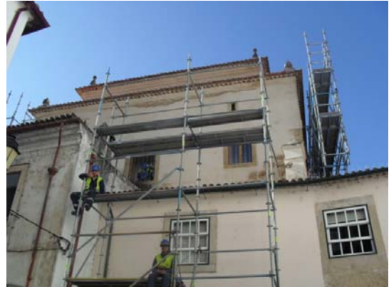
Viga parte do suporte do andaime poente, na fachada sul e estrutura na fachada nascente, antes de ligada ao restante
