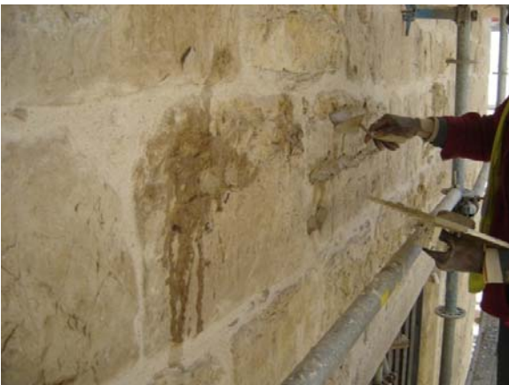
Execução de micro-estucagem, no exterior e no interior antes da esponjagem
