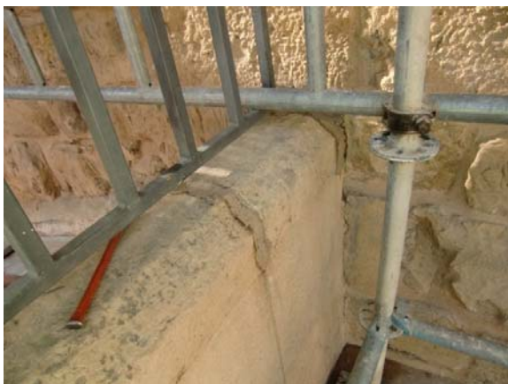
Tratamento de juntas no patamar da entrada.
