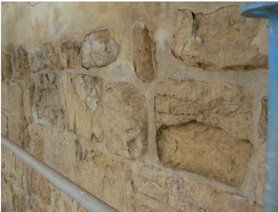
Juntas em cimento "Portland", em destacamento, justificando a utilização de equipamento elétrico ligeiro.
