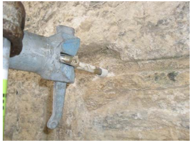
Viga parte do suporte do andaime poente, na fachada sul e estrutura na fachada nascente, antes de ligada ao restante
