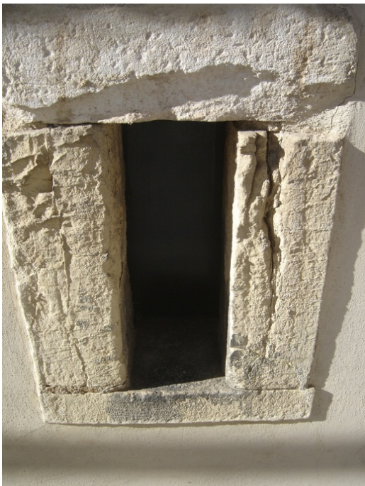
Vão em cantaria, antes e depois da micro-estucagem.
