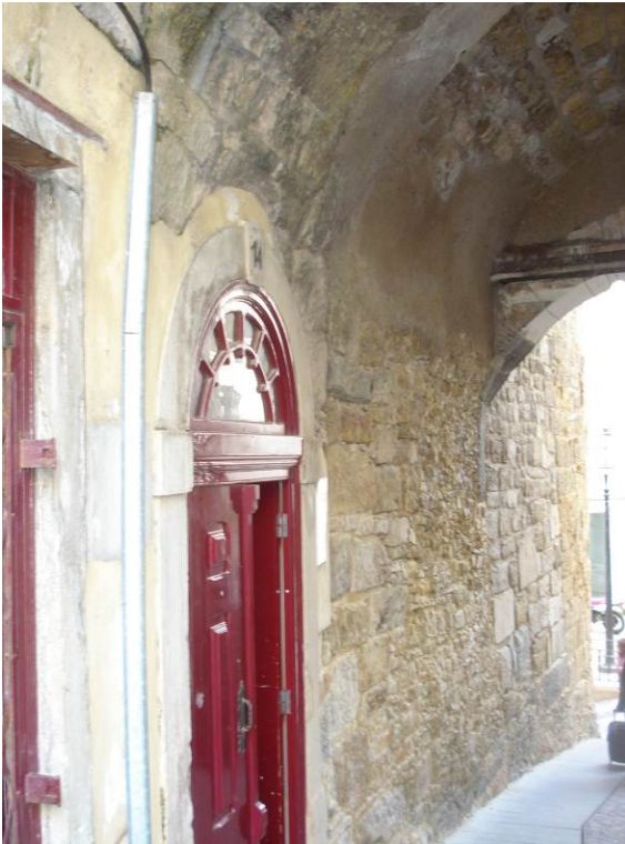
Paramentos no interior do Arco, antes da intervenção
