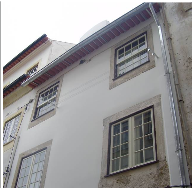
Depois da intervenção
