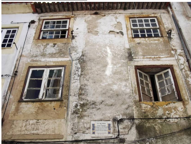
Antes da intervenção
