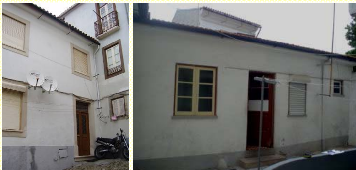
Antes da intervenção
