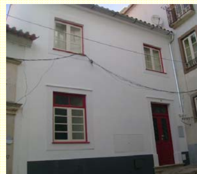
Depois da intervenção
