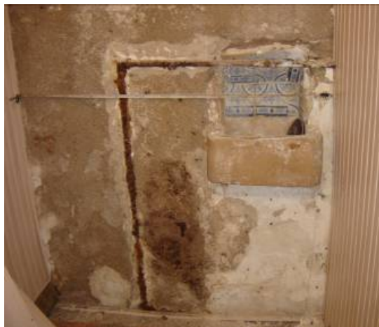
Figura 3 - Pias assinaladas na fachada sul e este.
