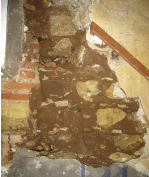
Figura 2 - Pormenor do aparelho construtivo da fachada
