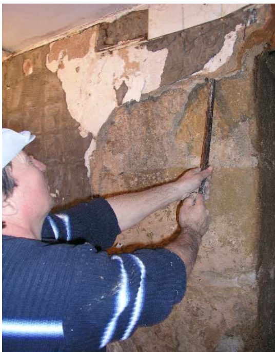
Remoção de argamassas inerentes ao projecto de empreitada e aspecto do cunhal em evidência
