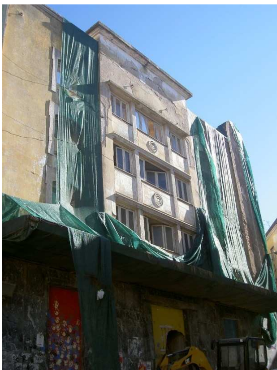
Estado actual do edifício do extinto Teatro Sousa Bastos, na sua maioria desprovido de cobertura e de miolo e fachadas com janelas partidas, rebocos soltos, vegetação nos beirados.
