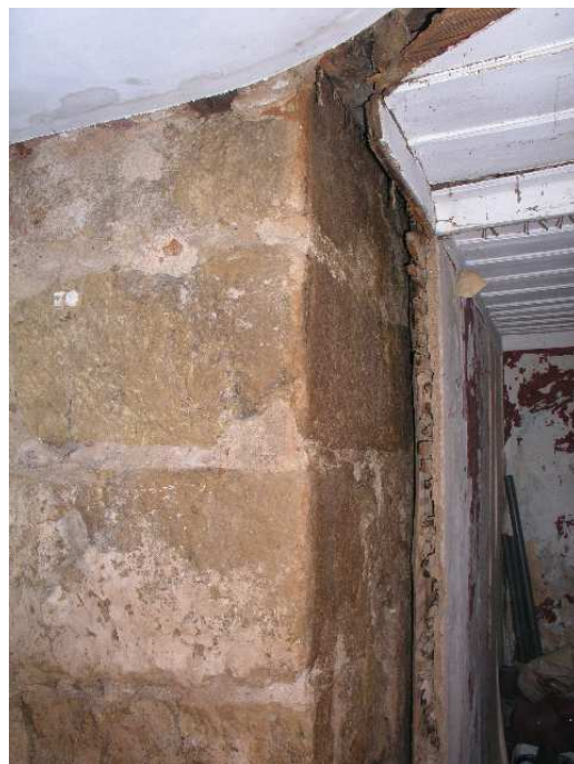
Remoção de argamassas inerentes ao projecto de empreitada e aspecto do cunhal em evidência
