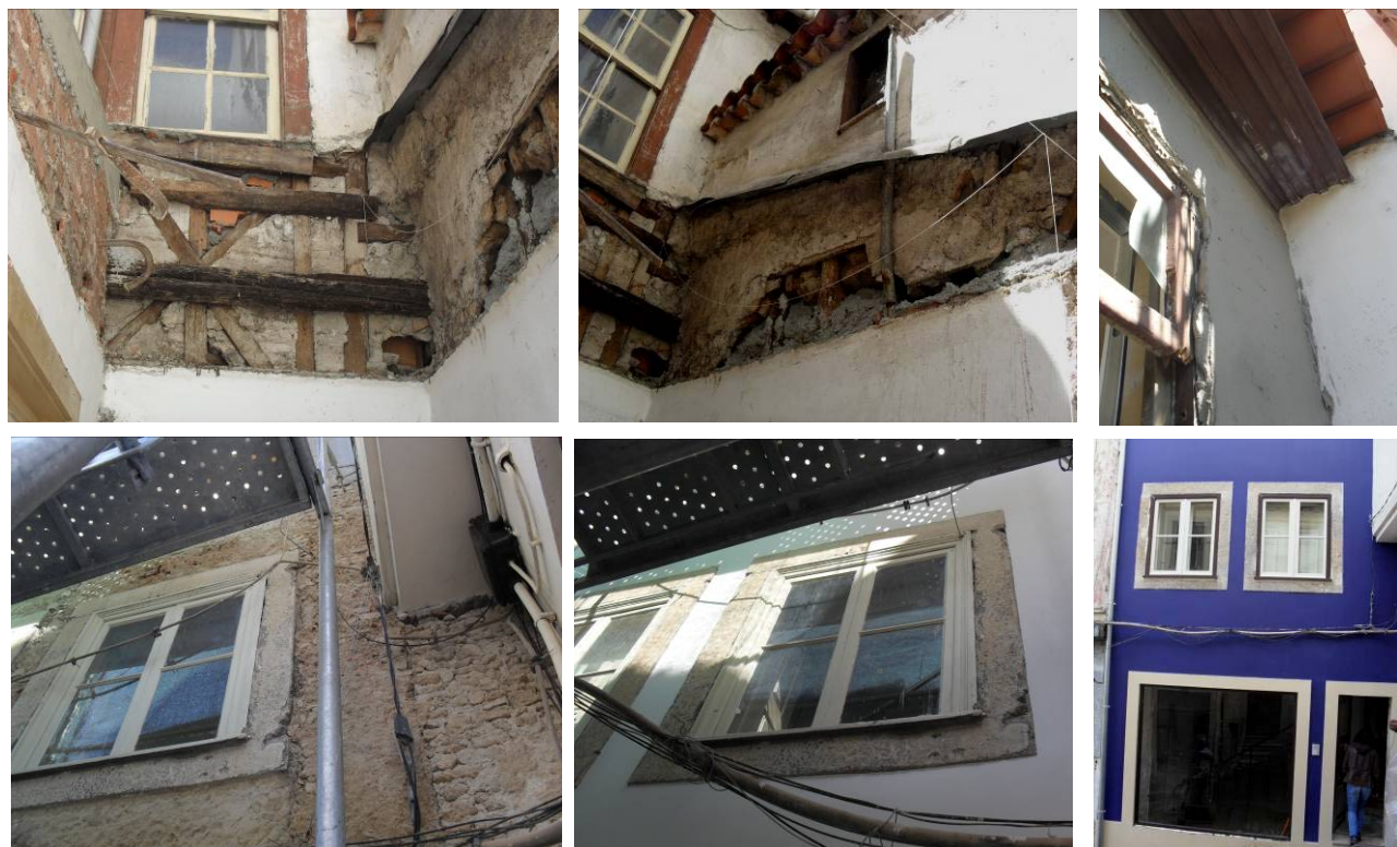
Recuperação do reboco das Fachadas
