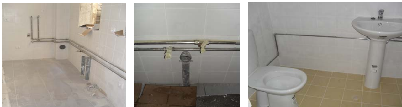
Execução de Infra-estruturas
