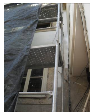
Montagem de andaimes e de rede de protecção
