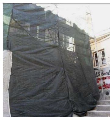
Montagem de andaimes e de rede de protecção
