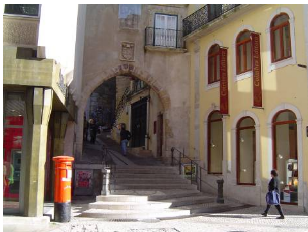
Aspecto antes da intervenção
