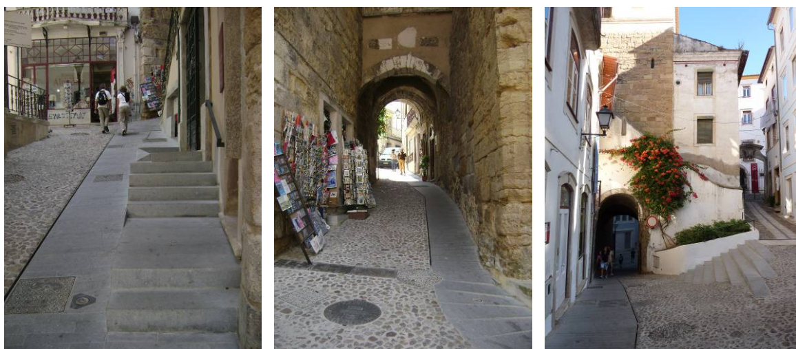
Faixa contínua em granito num dos lados da rua, que tem maior atrito que o calcário, para melhorar as acessibilidades.
