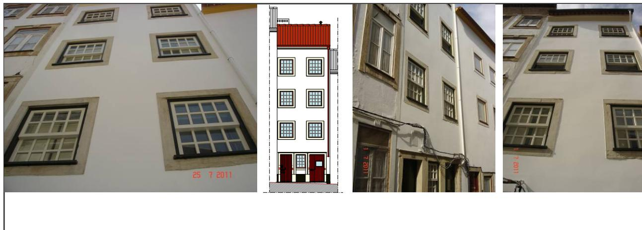
O soco foi limpo e no local onde não existia (nomeadamente onde existia caixa de contador) executou-se reboco liso com 0,5 cm de espessura, em "argamassa pobre", e posteriormente pintou-se à cor Pedra, cor aferida no local.
