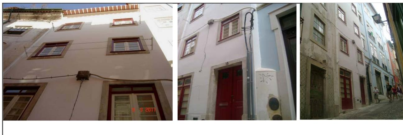
O soco foi limpo e no local onde não existia (nomeadamente onde existia caixa de contador) executou-se reboco liso com 0,5 cm de espessura, em "argamassa pobre", e posteriormente pintou-se à cor Pedra, aferida no local.
