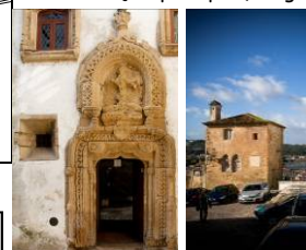
Paço Sub-Ripas Torre do Anto
