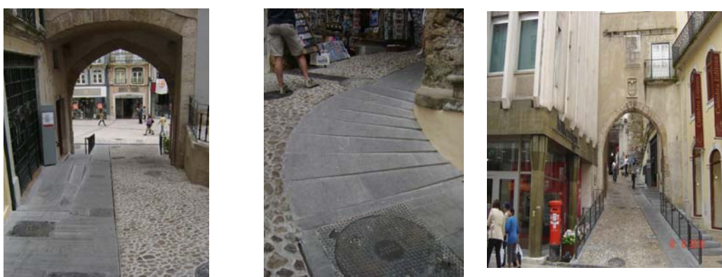
Remodelação das Escadas do Quebra-costas e Rua do Arco de Almedina – 1ª Fase – Rua do Arco de Almedina
