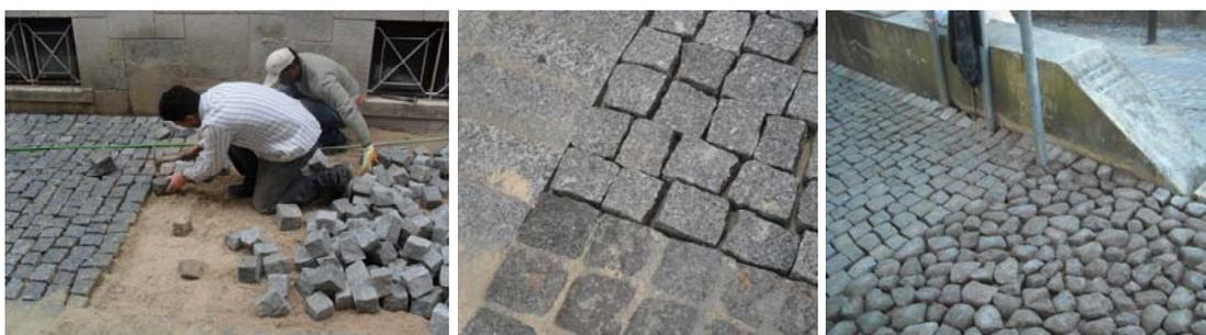
Aplicação da calçada de cubo de granito para posterior rejuntamento e limpeza final
