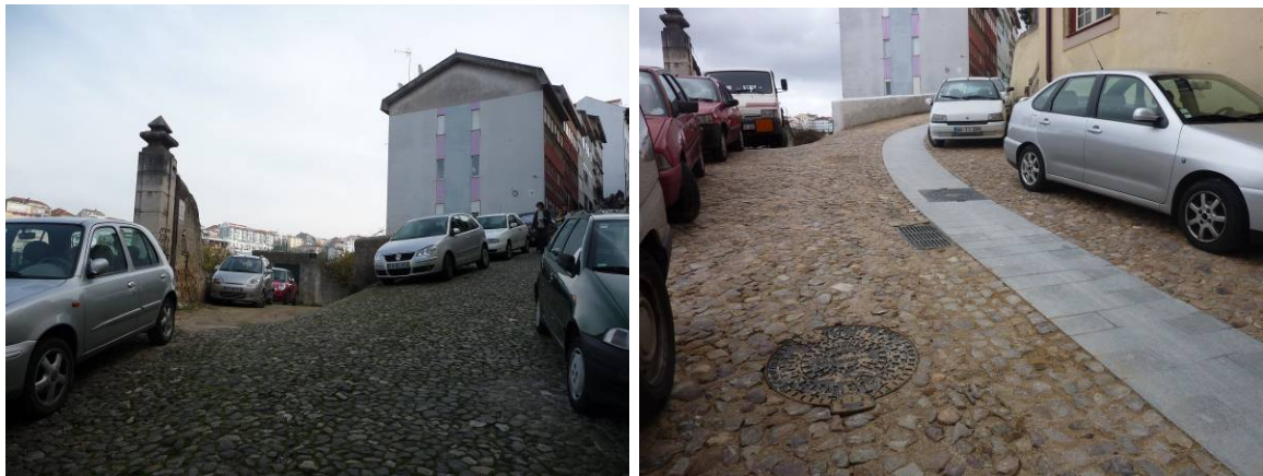
Passadeira central e valeta na zona da curva da Couraça dos Apóstolos, situação antes e depois da intervenção
