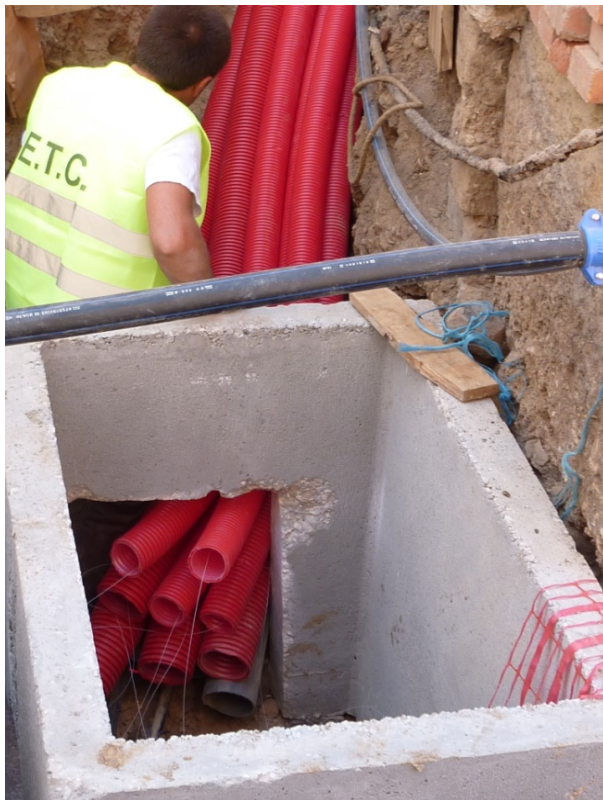
Tubagens vermelhas para rede eléctrica e verdes para ITED
