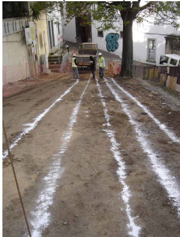
Viatura de inspecções das AC, EM e alinhamento inicial das diversas condutas
