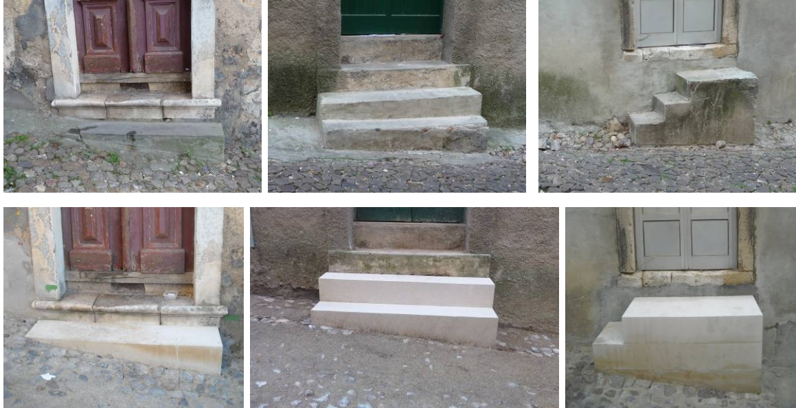
Substituição dos degraus existentes.
