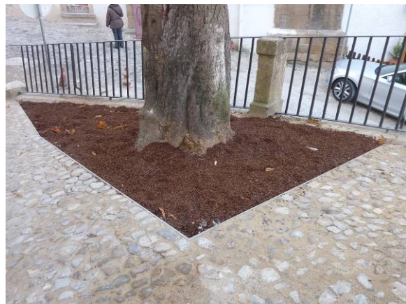
Caldeira do Castanheiro-da-índia inexistente antes da intervenção. O seixo remata num perfil metálico e a caldeira é cheia por casca de pinheiro.
