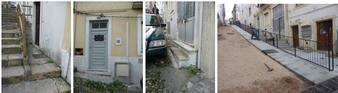
Situação das soleiras antes e depois da transformação das escadas.
