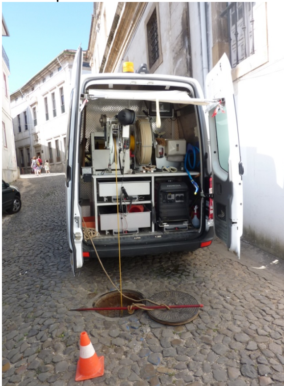
Viatura de inspecções das AC, EM e alinhamento inicial das diversas condutas
