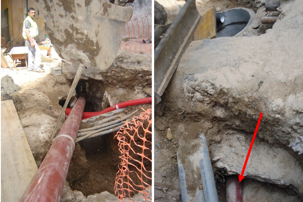
Conduto de FFD, na Travessa da Esperança e sob os vestígios arqueológicos, junto à Cerca de Santo Agostinho
