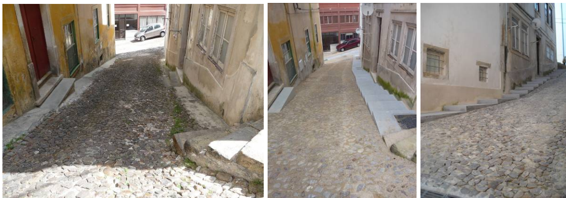
Foram criadas escadas-rampa no lado poente da Travessa da Esperança cujo remate superior acontece em degraus previamente existentes.
