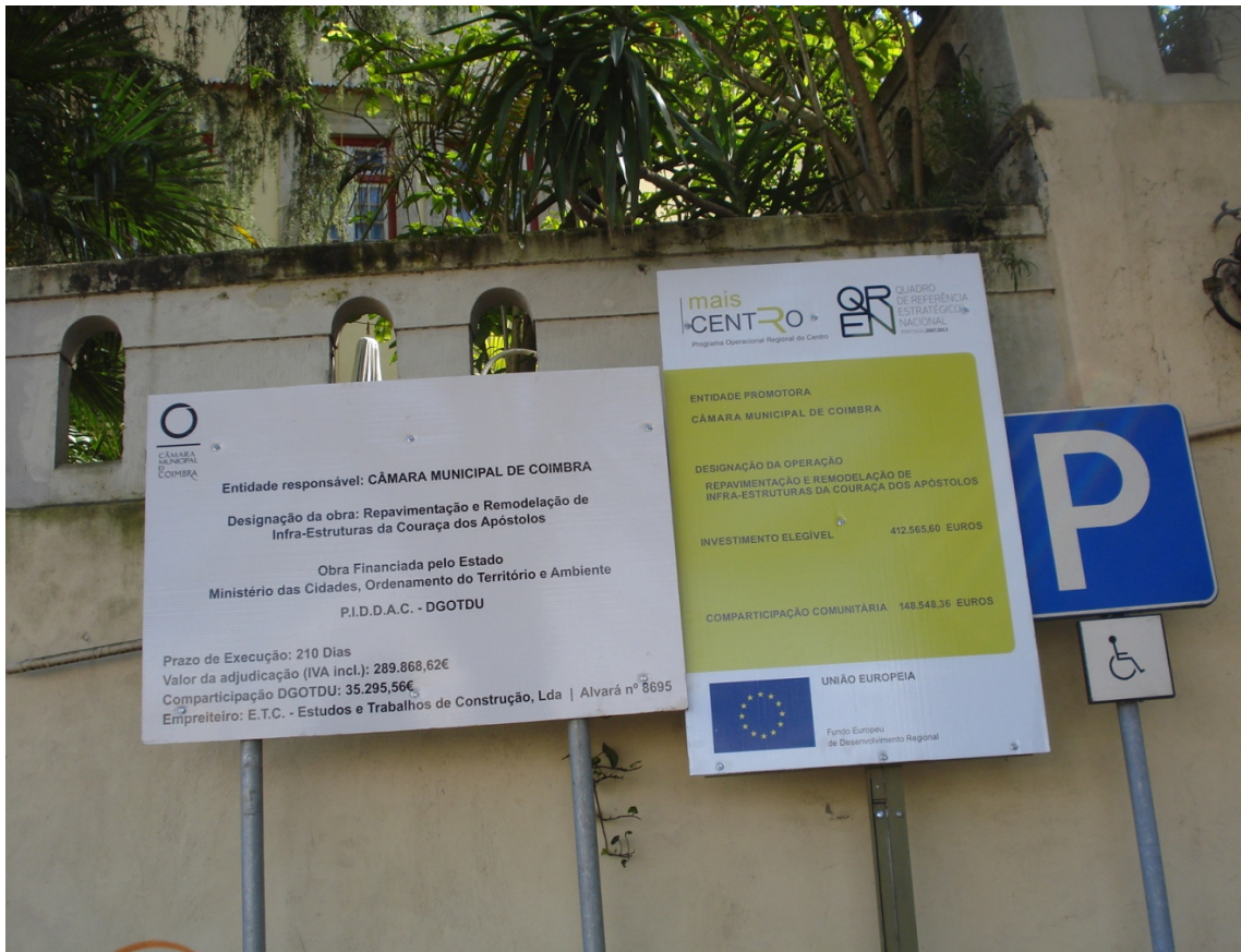
Placas identificativas da obra
