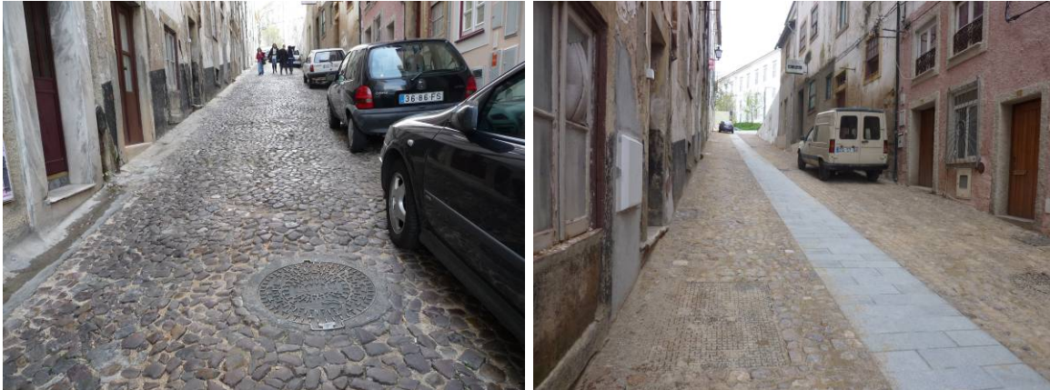
Passadeira central e valeta na parte superior da Couraça dos Apóstolos, situação antes e depois da intervenção.
