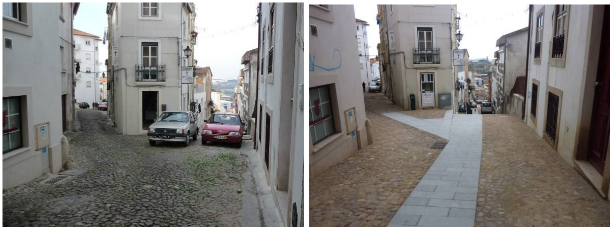
Entroncamento da Rua Dr. João Jacinto na Couraça dos Apóstolos, situação antes e depois da intervenção.
