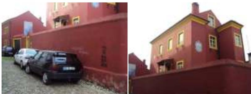
**Figura 7** – Rua de São Cristóvão - Neste caso não foram respeitadas as cores originais. O Gabinete para o Centro Histórico está sempre disponível para prestar apoio. Aplicação indevida de caixilharia de alumínio nas janelas que originalmente eram em madeira e terão futuramente de ser substituídas
