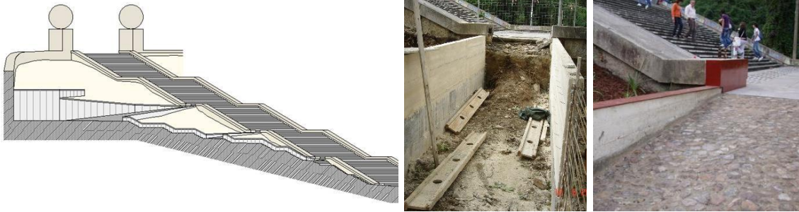
Ligação das rampas aos patamares das Escadas Monumentais
