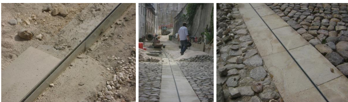
Execução dos trabalhos de acabamento do 'canelete' de escoamento das águas pluviais
