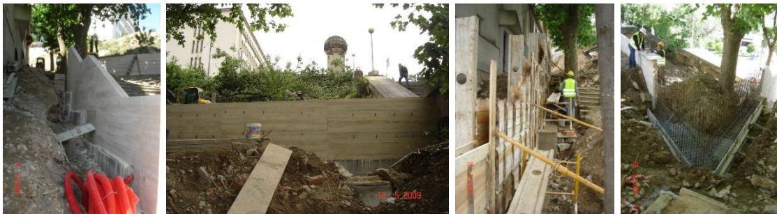
Execução de muros de suporte de terras que sustentam taludes ajardinados
