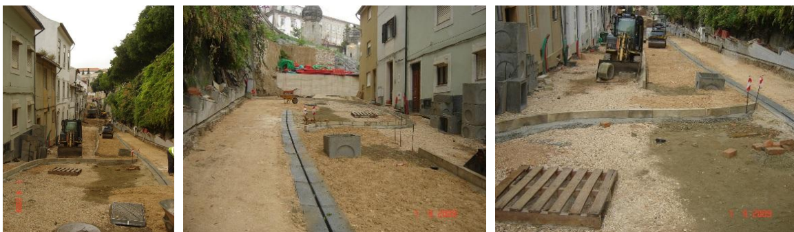
Execução da base para a caleira sumidoura contínua (canelete)
