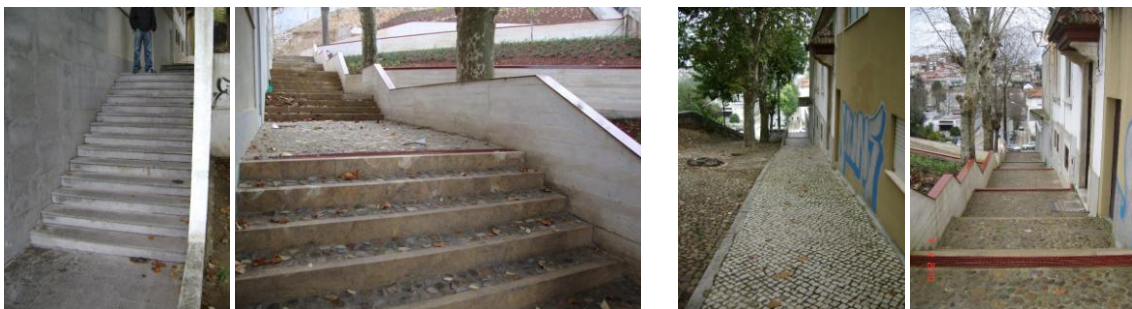
"Antes e Depois" - Vista inferior e superior das escadas junto aos edifícios
