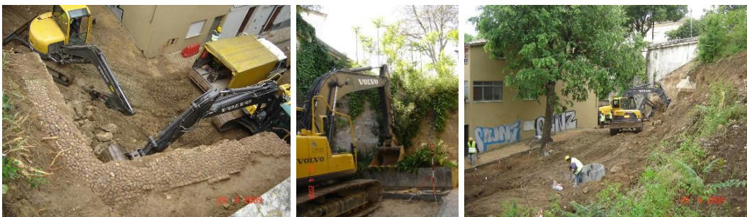
O início dos trabalhos - movimento de terras
