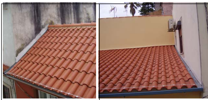
revessas metálicas em zinco
