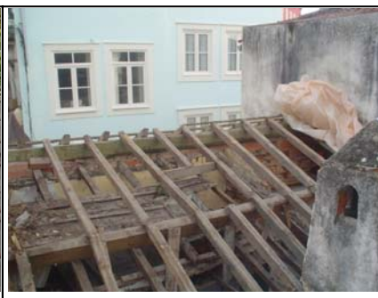
alçado posterior - estrutura de suporte
