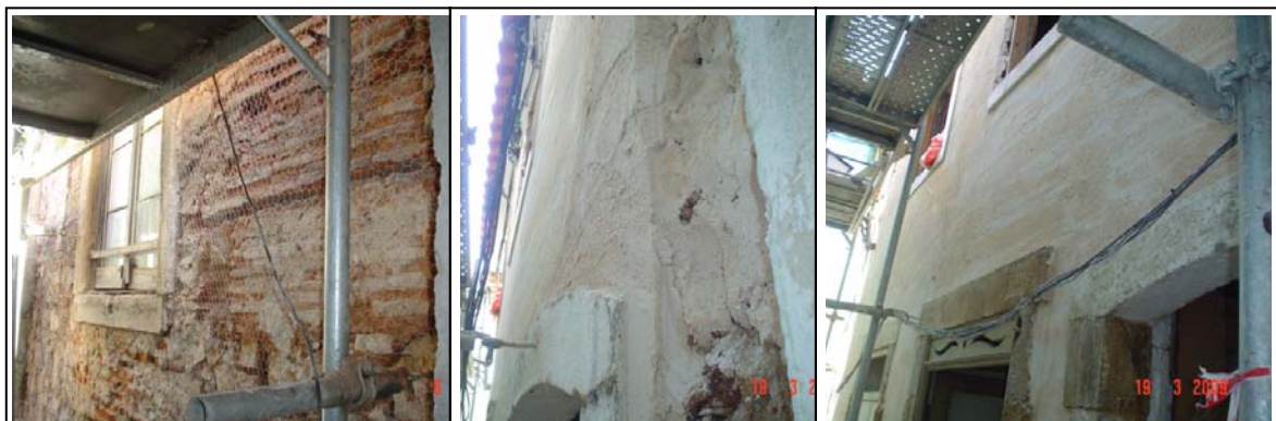
aplicação de rede
