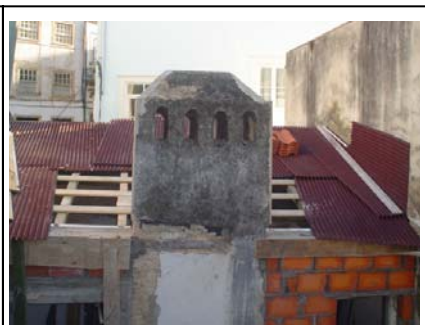
alçado posterior - sub-telha
