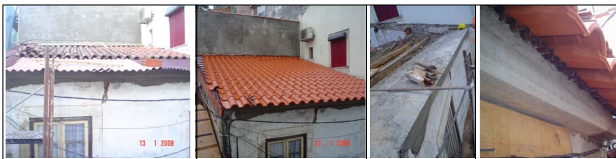
Alçado principal - execução de nova estrutura de suporte da cobertura, incluindo a viga capeamento perimetral
