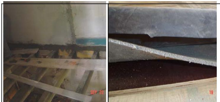
novas vigas de madeira
