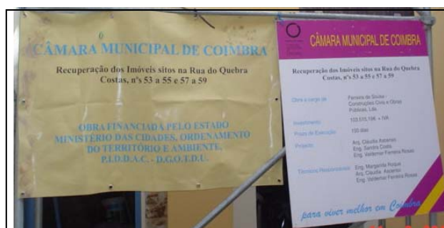
Placas identificativas da obra
