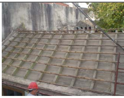
alçado principal - estrutura de suporte
