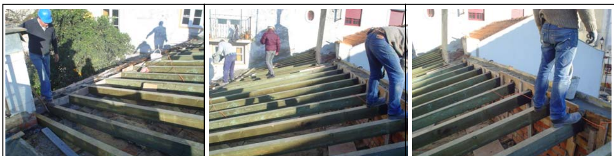
Alçado posterior - execução de nova estrutura de suporte da cobertura
