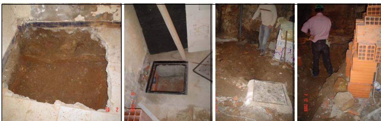
esgotos domésticos - caixas de visita
