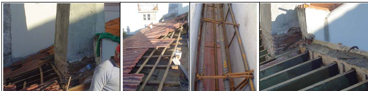
Alçado posterior - telha cerâmica e estrutura de suporte
