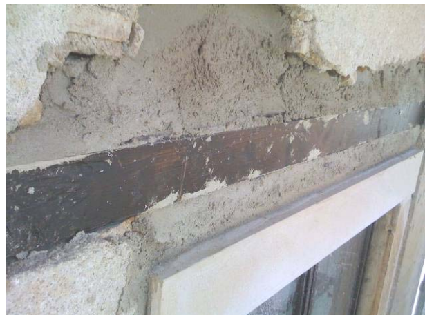
Colocação de nova cantaria de pedra e da padieira de madeira
