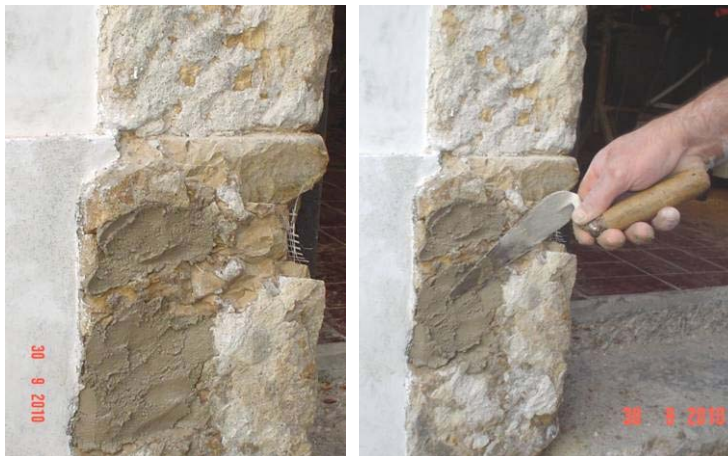
Reparação de cantaria de pedra com lacuna, com a execução de ancoragens
