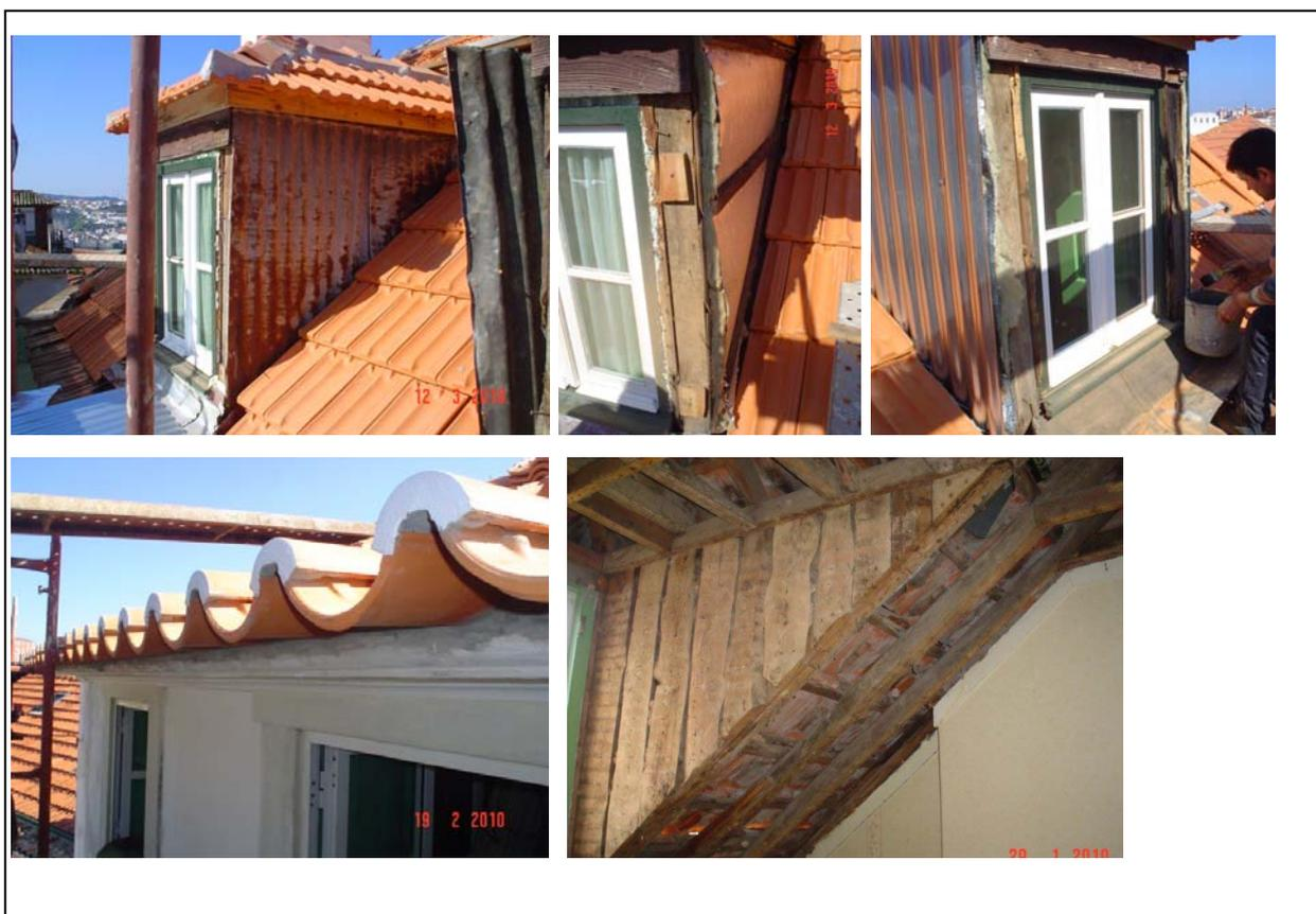
O beirado foi executado com telha "bica e capa" de encaixe especial da "Estrela d'Álva".
