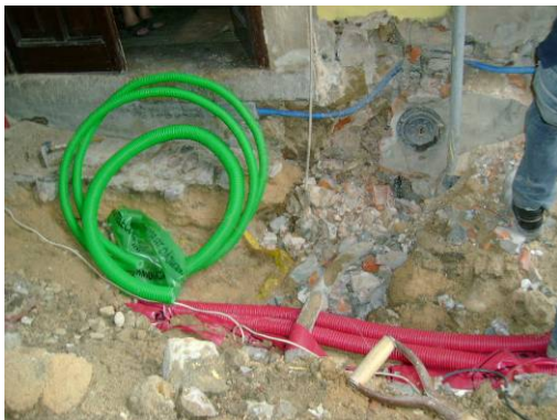
Execução de caixas e roços para colocação de Infra-estruturas
