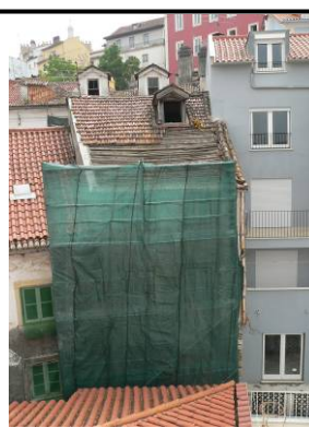
Montagem de andaimes e de rede de protecção
