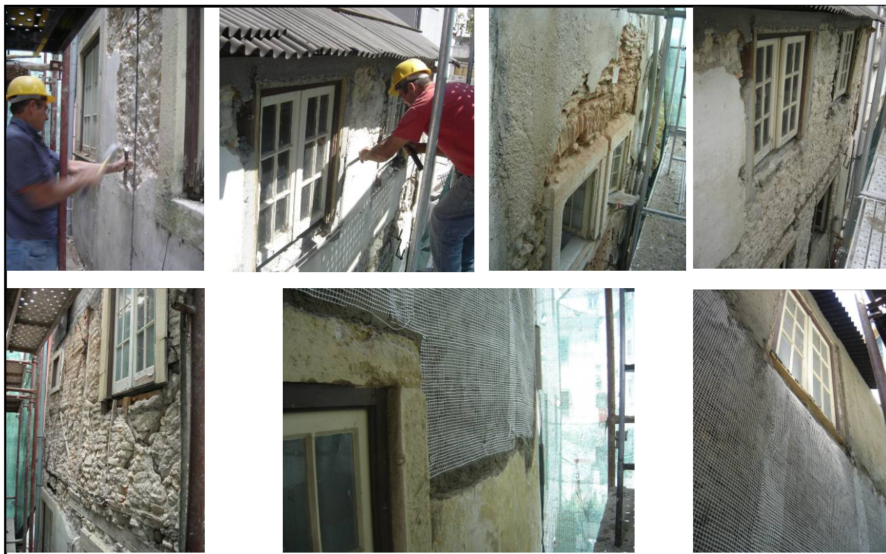
Remoção pontual e execução de rebocos
