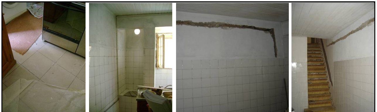
Recuperação de interiores
