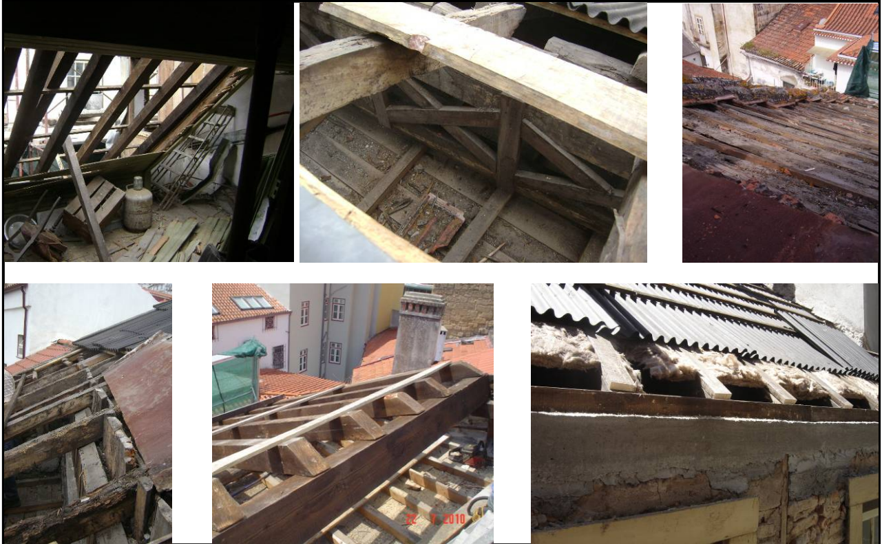
Trabalhos de recuperação da cobertura
