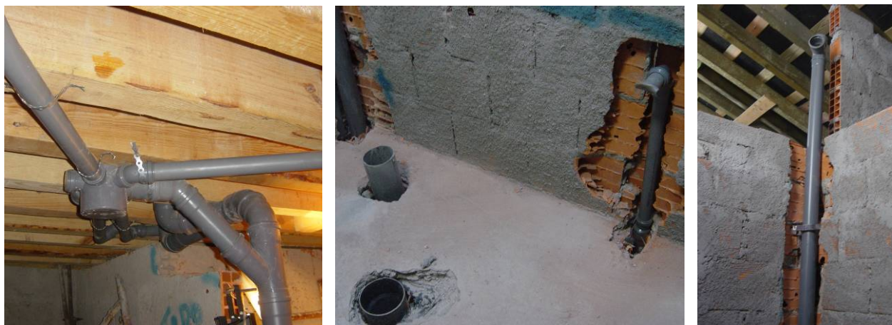
Execução de nova rede de drenagem de esgotos domésticos
