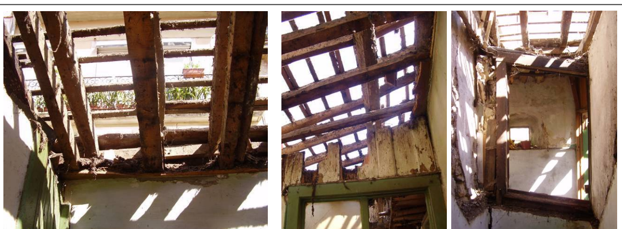
Estrutura de suporte da cobertura antes da intervenção
