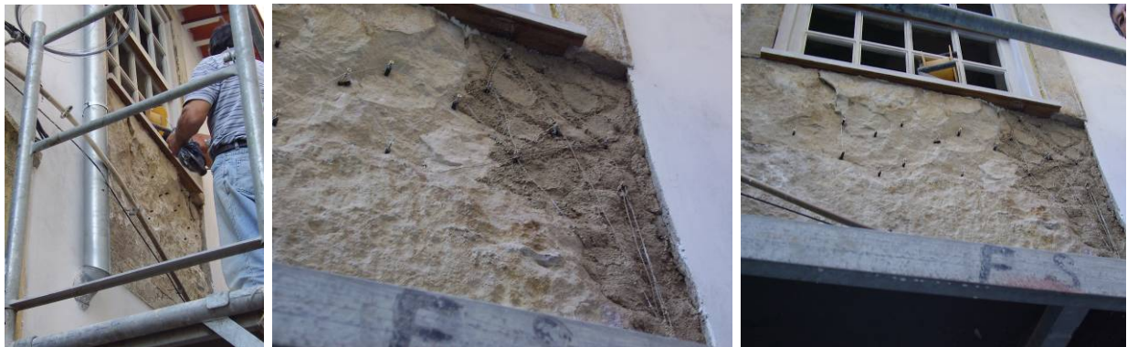
Trabalhos de recuperação das cantarias
