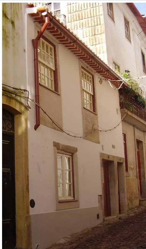
Depois da intervenção
