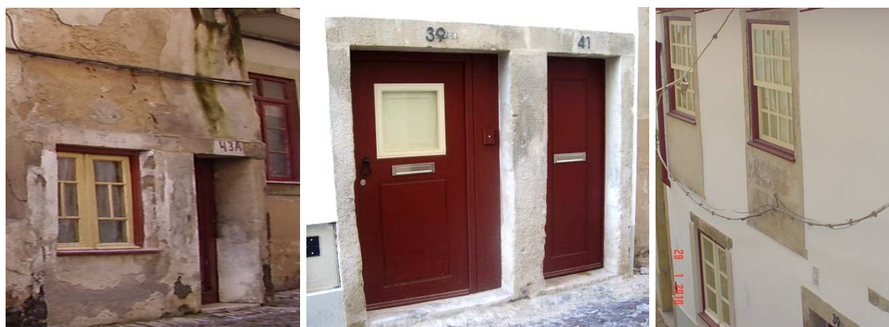
Reposição de situação original dos vãos
