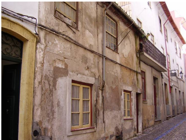
Imóvel antes da recuperação
