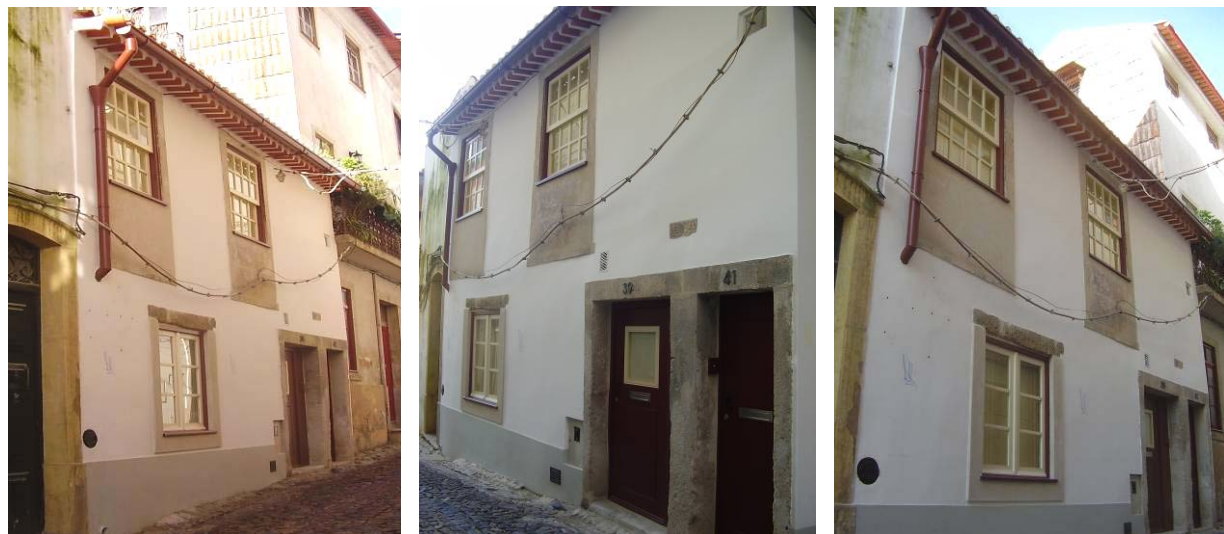
Foto da fachada principal com cores aferidas em obra
