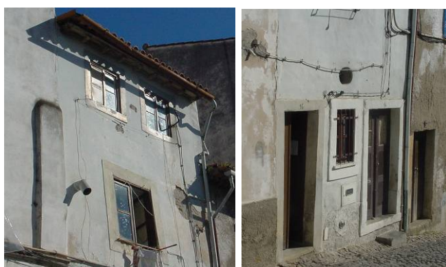
Caleira e tubo de queda
