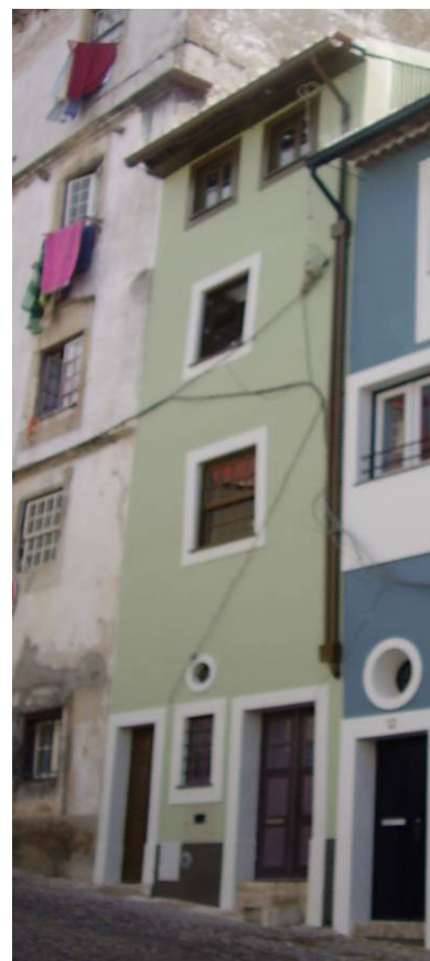
Depois da intervenção
