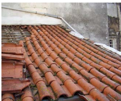
Estrutura de suporte da cobertura antes da intervenção
