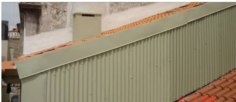
Cobertura depois da intervenção
