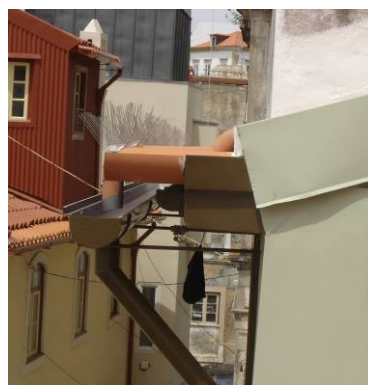
Sistema de drenagem
