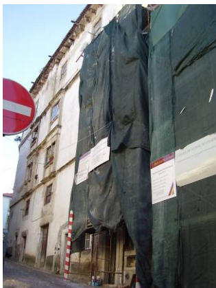
Montagem de andaimes, rede de protecção e área reservada a estaleiro
