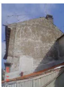
Material cerâmico de revestimento da cobertura envelhecido e remates laterais imperfeitos
