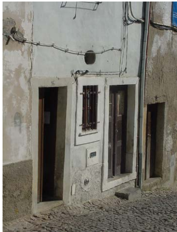
Antes da intervenção
