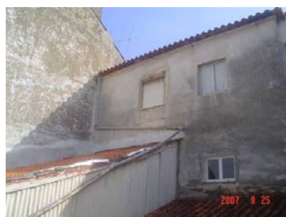
Material cerâmico de revestimento da cobertura envelhecido e remates laterais imperfeitos
