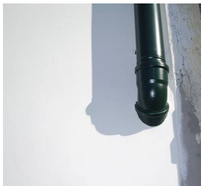
Sistema de drenagem - troço vertical do tubo de queda, em PVC, embebido ao nível do rés do chão
