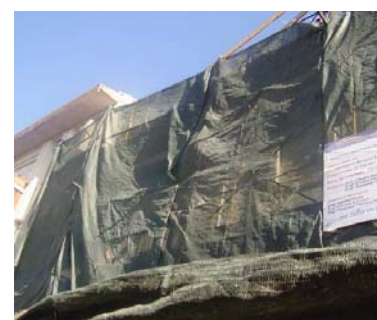
Rede de protecção
