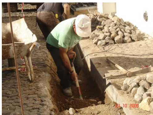
Foto 1 - Abertura de vala
