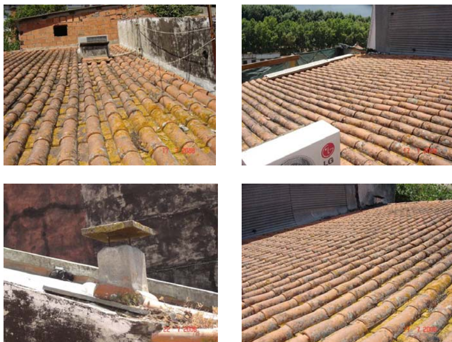
Vista do revestimento da cobertura e chaminés
