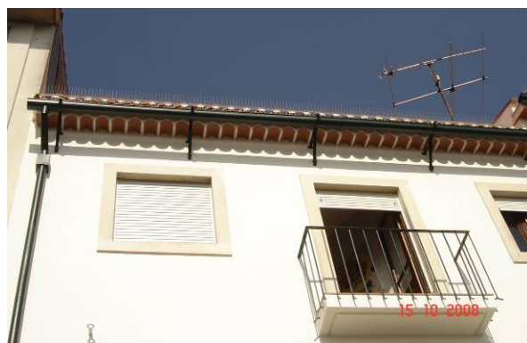
Sistema de drenagem - tubos de queda, caleiras e funis de descarga
