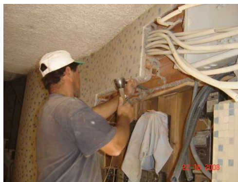
Foto 2 - Abertura de roços
