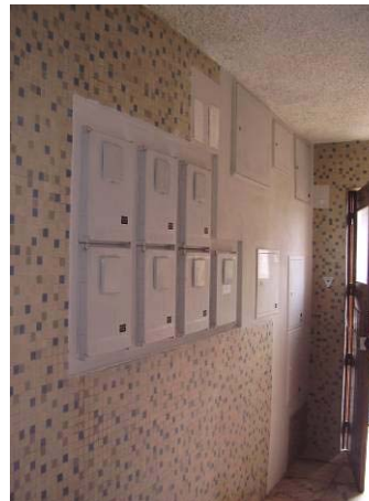
Sinalização de emergência, caixa de contadores e quadros eléctricos conforme imposições regulamentares
