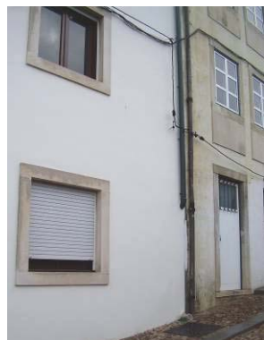
Sistema de drenagem - troço vertical do tubo de queda, em PVC, embebido ao nível do rés do chão
