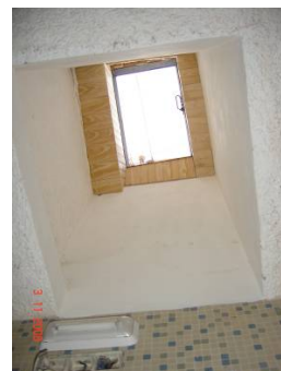
Trabalhos efectuados, pelo interior, para execução de acesso à cobertura
