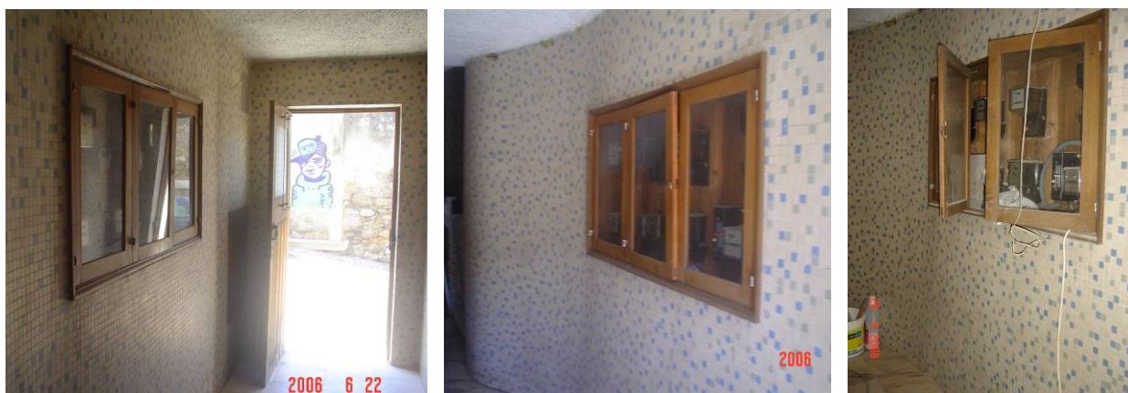
Quadro de entrada e caixas de contadores existentes
