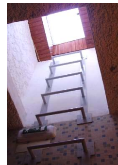
Trabalhos efectuados, pelo interior, para execução de acesso à cobertura
