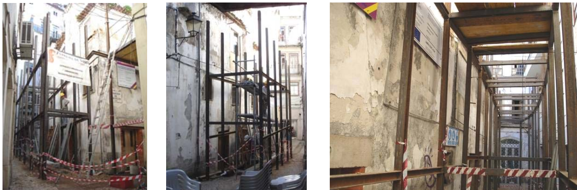
Contenção de fachadas
