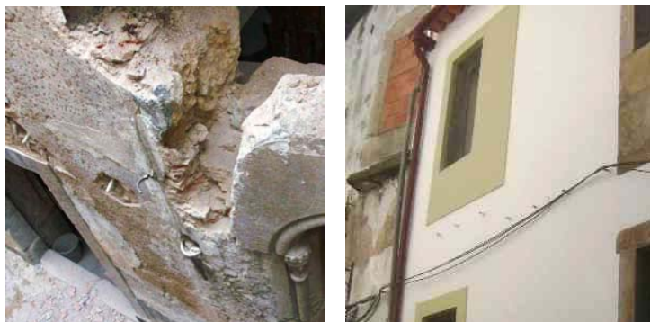
varões roscados durante a aplicação
