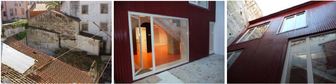
Cobertura e saguão - antes e depois
