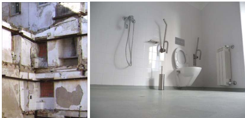
Interior do imóvel - antes e depois (instalação sanitária acessível)
