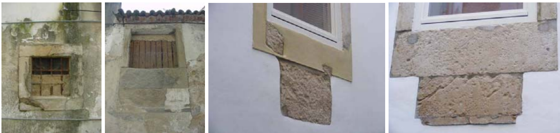
Vista parcial das Cantarias - antes e depois
