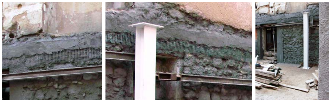
Aplicação da armadura em malha metálica para consolidação das paredes
