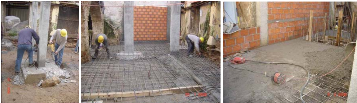
Execução do ensoleiramento geral
