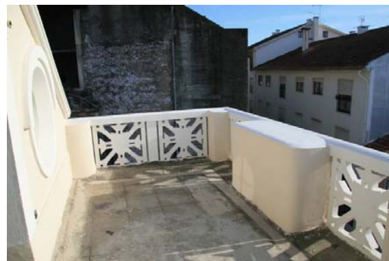
Trabalhos efectuados na cobertura e terraço existente ao nível das águas furçadas
