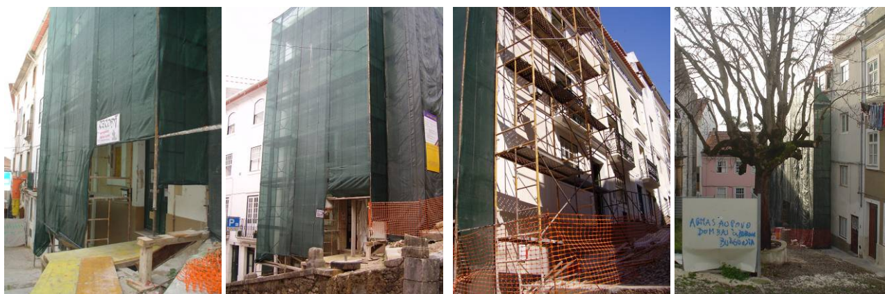
Montagem de andaimes e de rede de protecção
