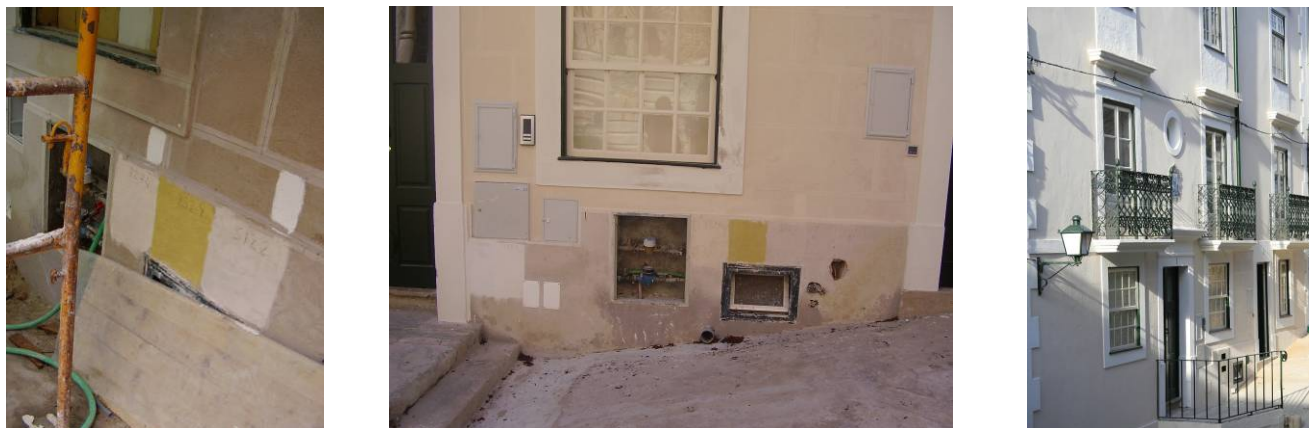
Trabalhos de recuperação efectuados na fachada
