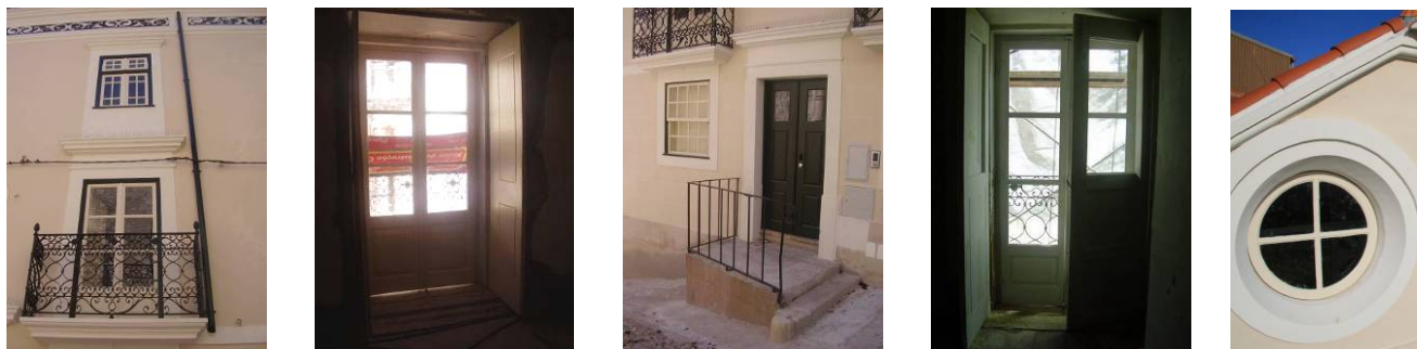
Vãos de portas e janelas recuperados
