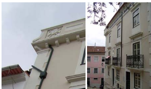
Sistema de drenagem
