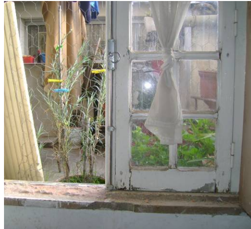
Envelhecimento das caixilharias e existência de peitoris em material pétreo
