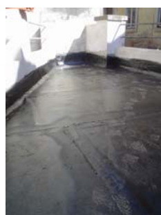
Colocação de tela asfáltica
