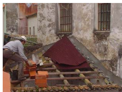
Estrutura de madeira da cobertura anexa
