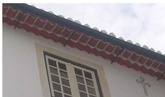
As telhas foram limpas com jacto de água e aplicado um "biocida", a argamassa das juntas foi refeita nas zonas necessárias, e pintada
