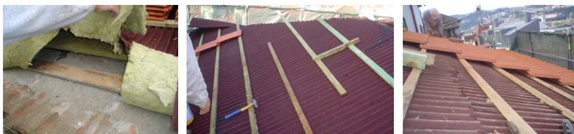
O isolamento térmico foi assente sobre a estrutura de suporte, após o qual foi aplicada a sub-telha
