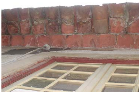
Beirado triplo com telhas parcialmente partidas, sujas e com ataque biológico
