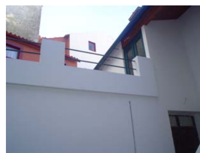
Acabamento dos muretes e gradeamento do terraço (vista do pátio inferior)
