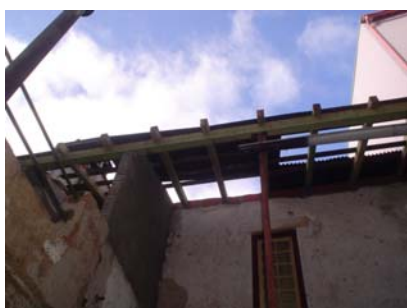
Na fachada posterior, a estrutura de suporte da cobertura foi prolongada para o vão de escadas
