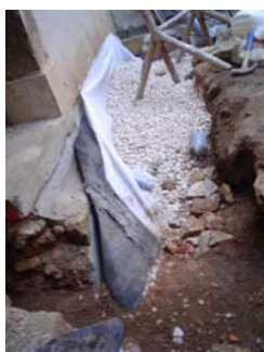
Execução do dreno no pátio
